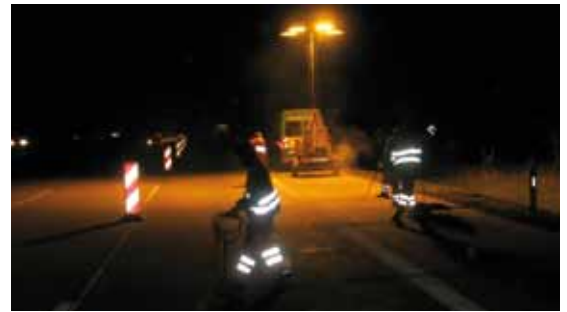
Erhaltungsmaßnahmen als Nachtbaustelle
