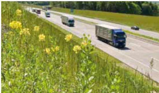
Straßenbauer und Naturschützer arbeiten Hand in Hand
