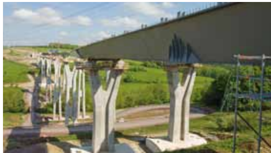
Neubau der Nesselstalbrücke
