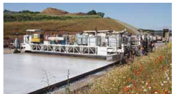
Betonage der Strecke
