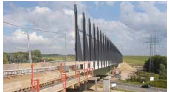
Neubau der Böbertalbrücke
