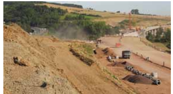
Neubau der Umfahrung
