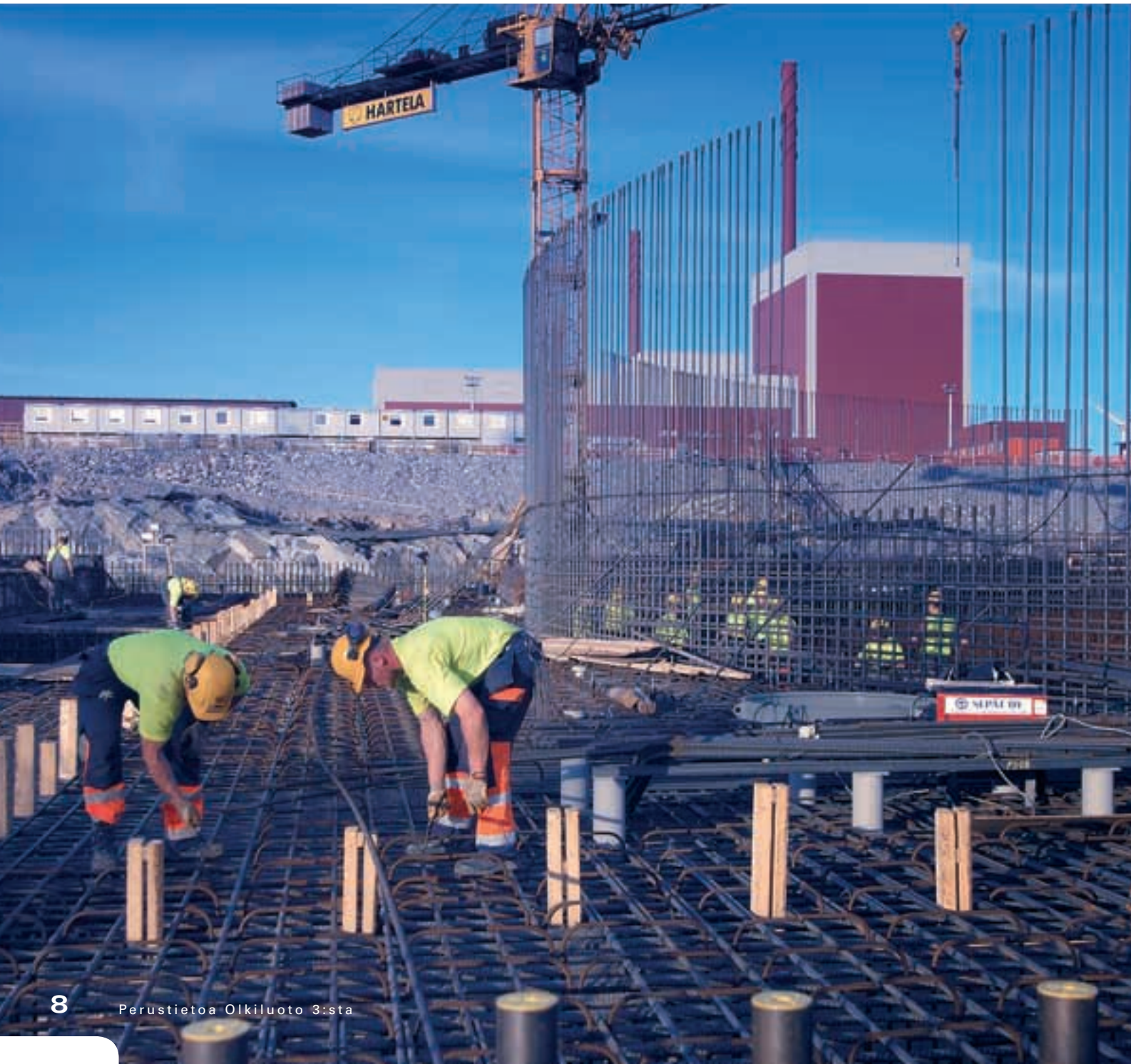
Pohjalaatan raudoitusyötä heinäkuussa 2005.
