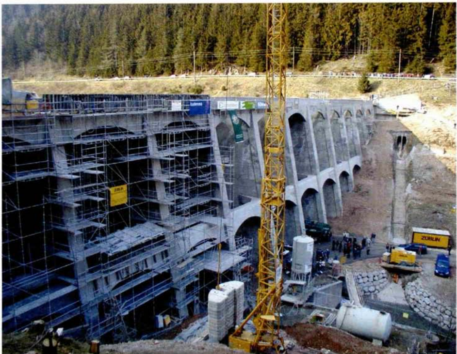
Betonsanierung der Luftseite (Stadtarchiv Vöhrenbach).
