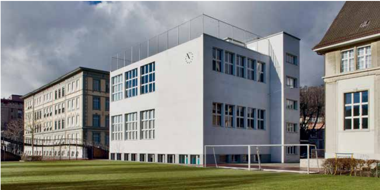
Die Dachterrasse der ehemaligen Doppelturnhalle diente ursprünglich als offener Gymnastikraum.
