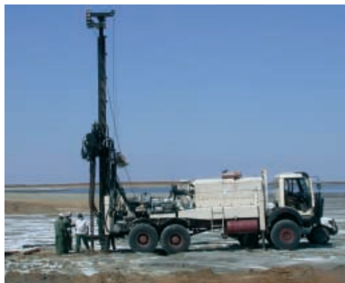
Bohrung auf der Halde mit Aufbereitungsrückständen der Cu-, Ni- und Co-Mine in Selebi-Phikwe, Botswana.
