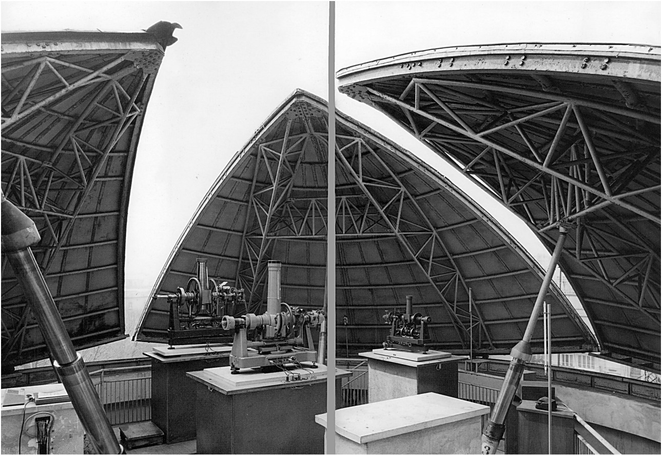
Figura 26: Gli strumenti dei passaggi installati negli anni '50 nella Cupola a fiore della sede di Brera dell'Osservatorio.
