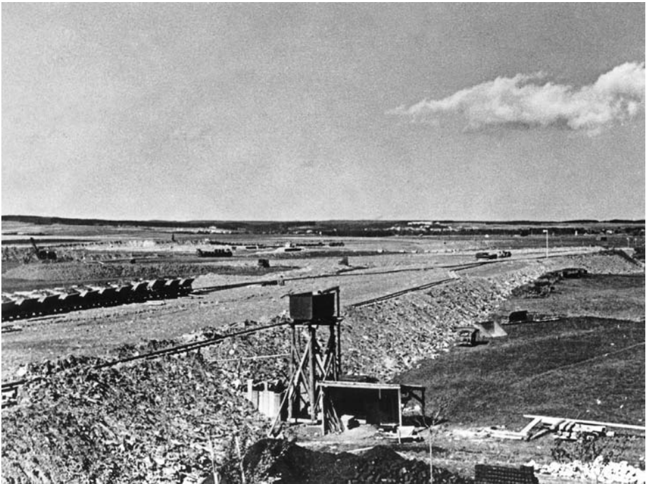
Um das Planum für das Hüttenwerk zu erstellen, waren gewaltige Geländeaufschüttungen nötig. Aufnahme vom Oktober 1940. Saarstahl AG.
