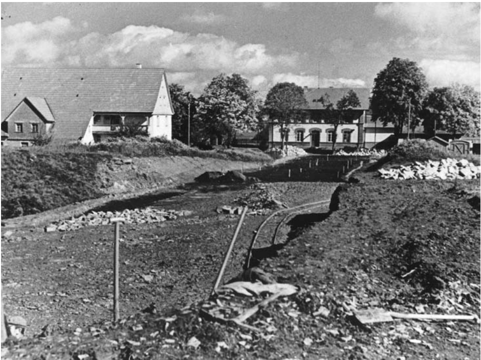
Im Oktober 1940 wurde die Zugangsstraße zum Hüttenwerk Neudingen gebaut. Saarstahl AG.
