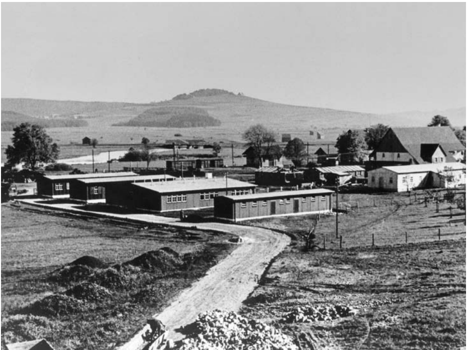
Das Barackenlager für etwa 570 Bauarbeiter war im Oktober 1940 bezugsfertig. Ganz rechts die weiße Küchenbaracke. Saarstahl AG.
