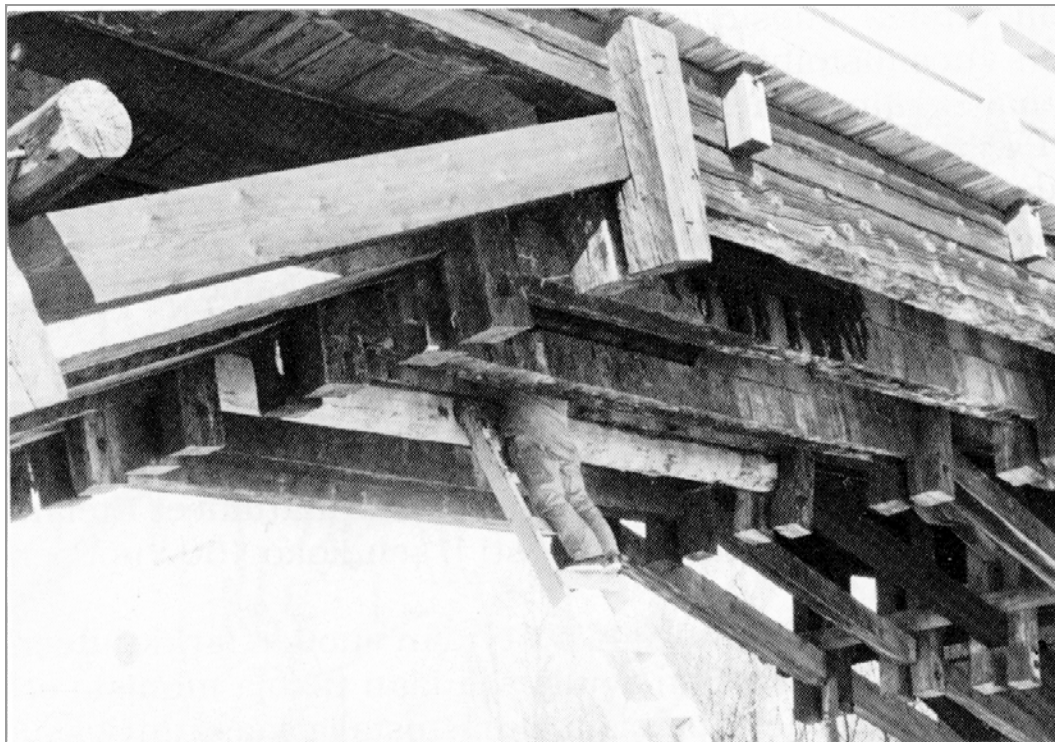
Isoasiltaa korjataan. Kuva vuodelta 1974.
