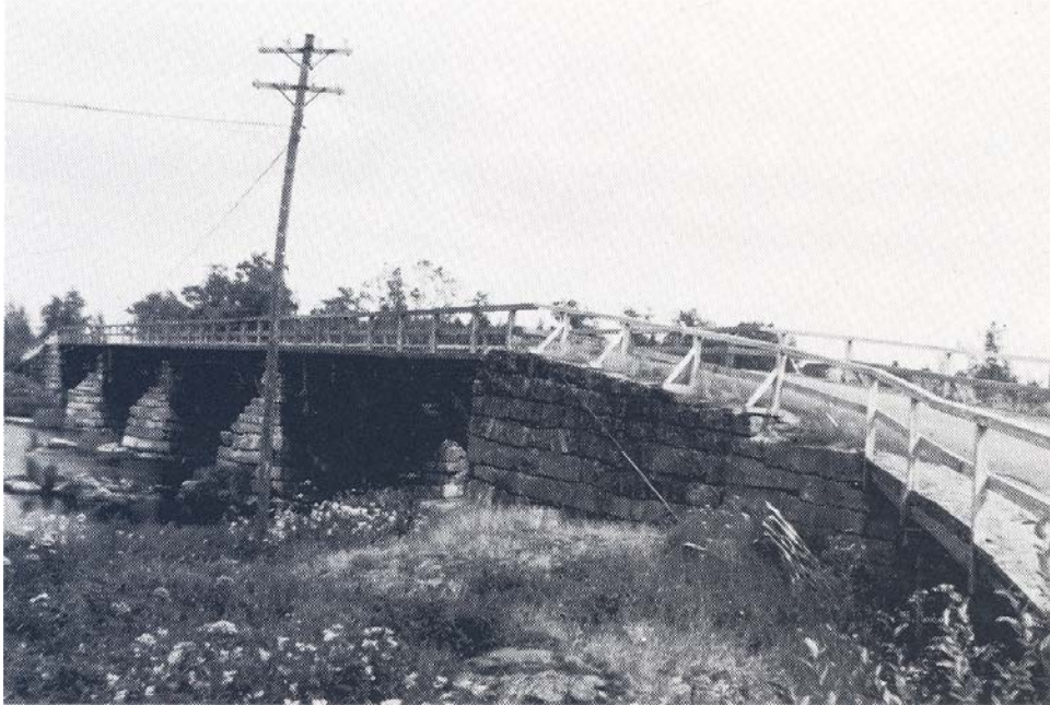
Etelänkylän ison sillan nousupenkere ja sen kivinen tukimuri.
