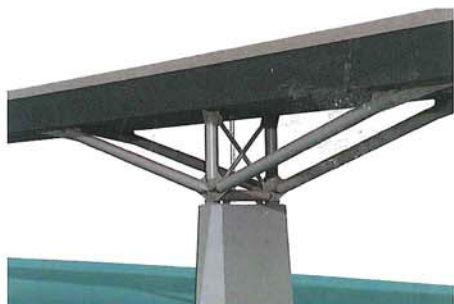
Figur 9. V-formede understøtninger af brodrager.
