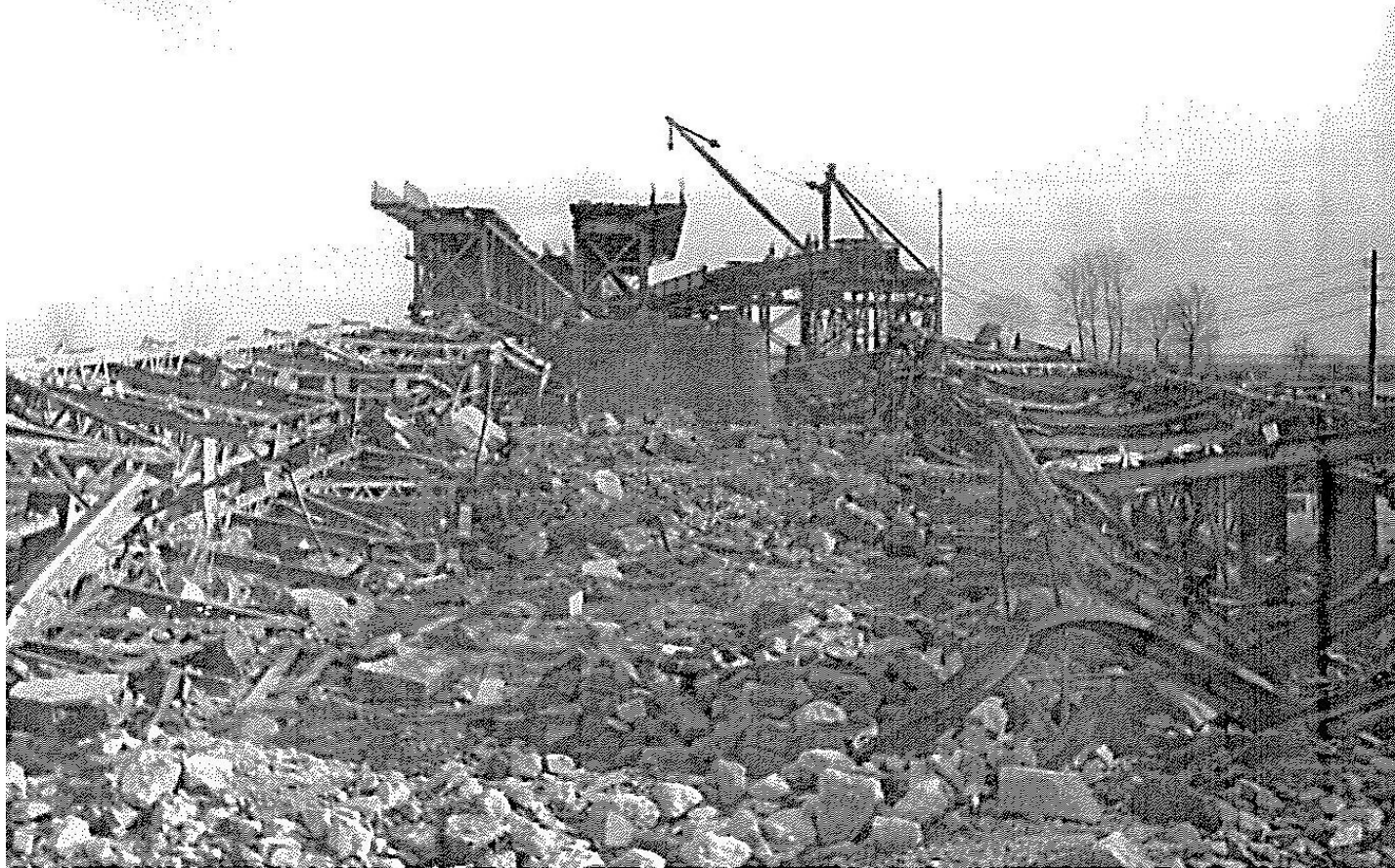
Bild 5: Teilweise zerstörte Rheinvorlandbrücke, Bereich Pfeiler 5 bis 7
