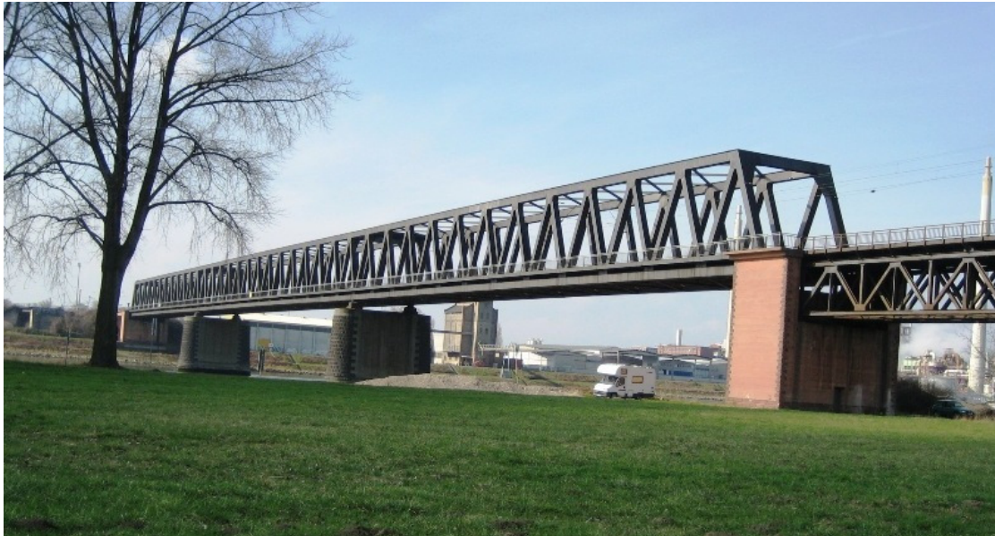
Bild 11.1: Rheinbrücke im Bestand, Ansicht von Südosten
