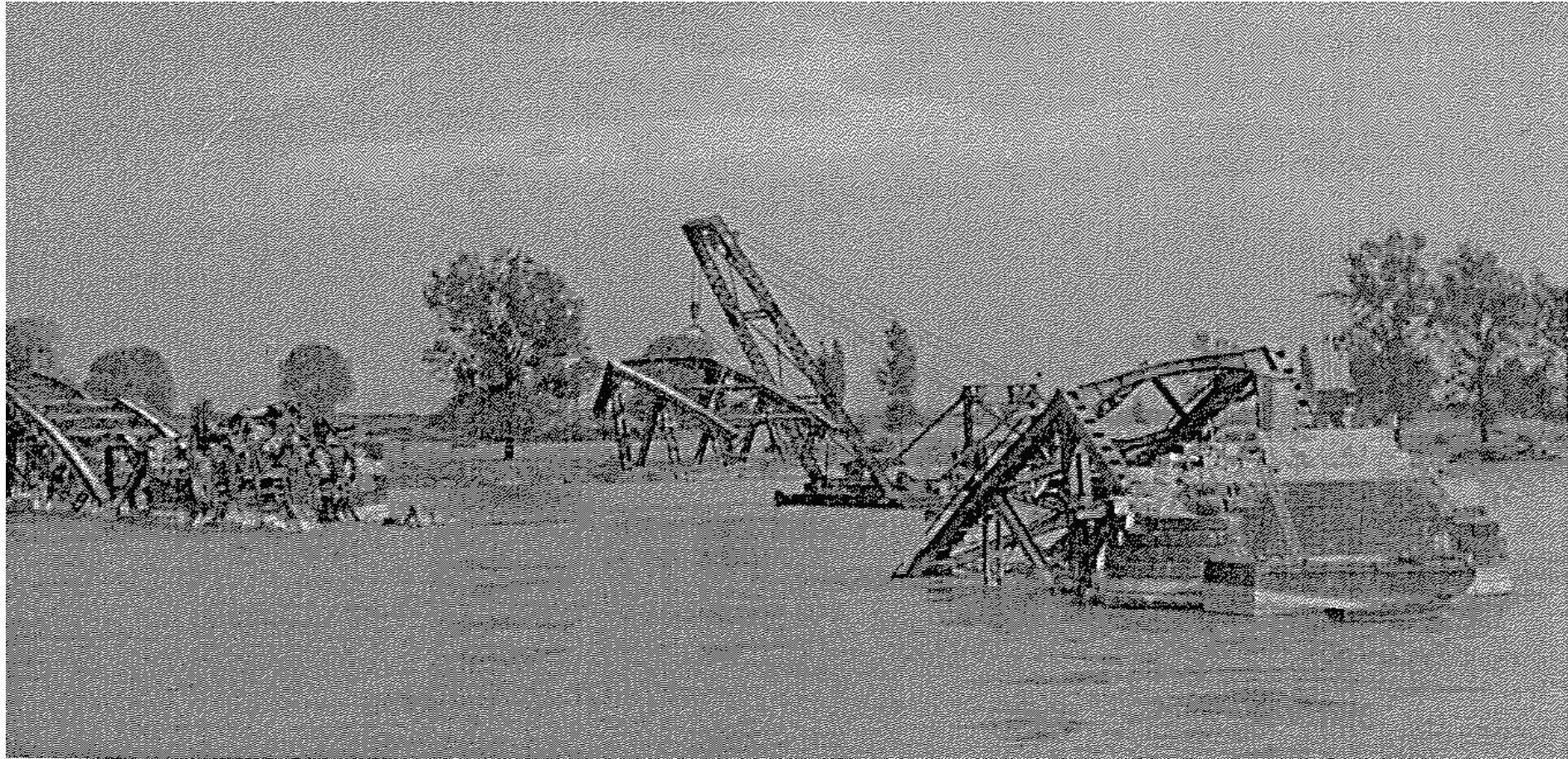
Bild 2: Freilegen der Fahrrinne
