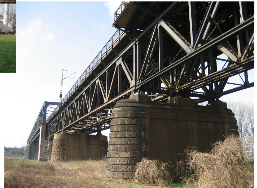
Bild 11.2: Rheinvorlandbrücke im Bestand, Pfeiler 7, Blick nach Westen
