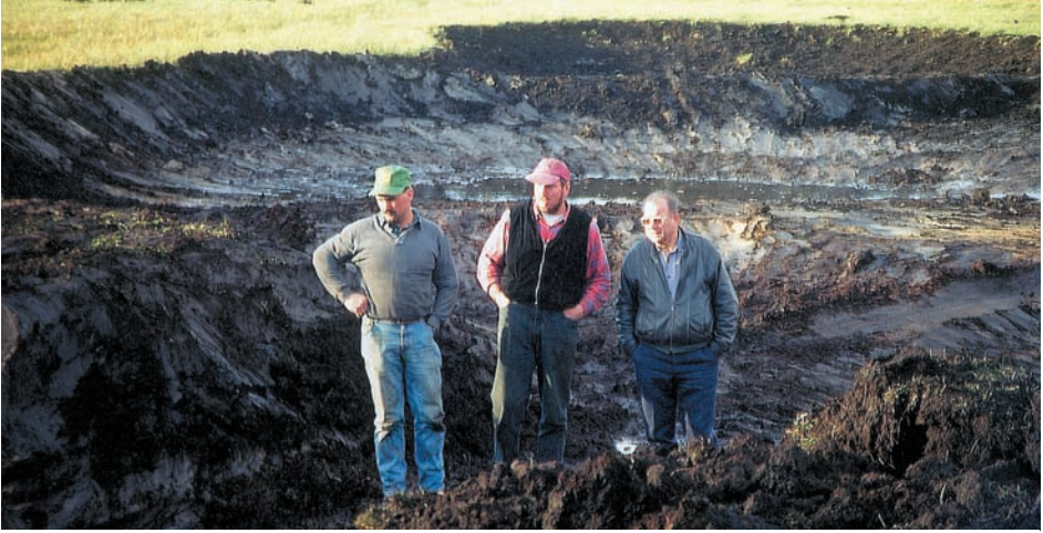
Abb. 1: Der neue Teich ist ausgebaggert (1997). Alle Fotos: Helmut Gehring.
