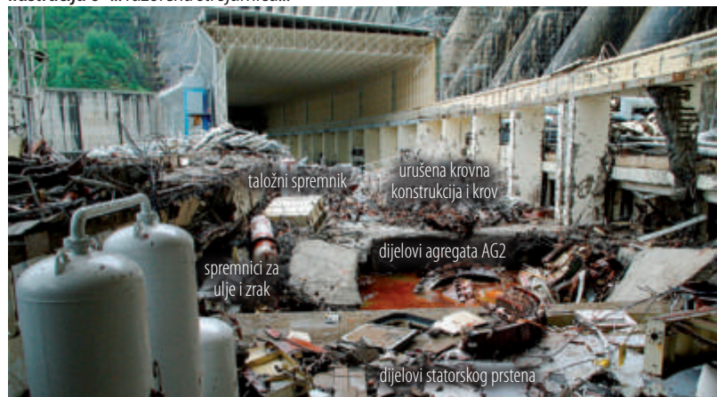
Ilustracija 6 ... razorenu strojarnicu...
