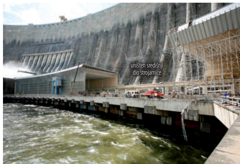
Ilustracija 5 Pogled na oštećenja u podnožju elektrane...
