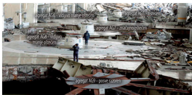
Ilustracija 7 ... i uništene agregate
