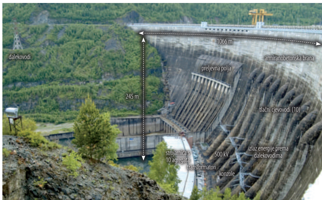
Ilustracija 2 Pogled na branu s naznakom osnovnih dijelova i dimenzija
