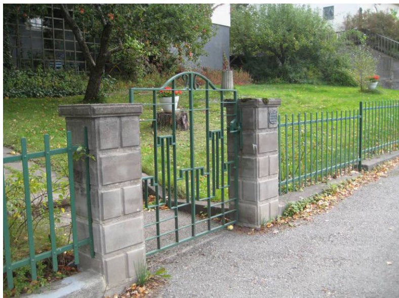
Låga smidesstaket, ofta med gjutna stolpar och individuellt utformad grindar är typiskt för området.
