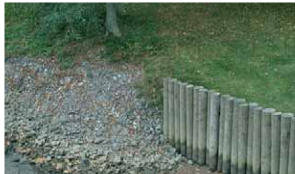
Eriyistä huomiota kiinnitetään pengerrakentamisen sopivuuteen kansalliseen kaupunkipuistoon. HN
