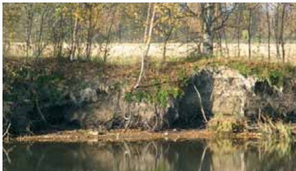
Luotojen alueen jokivarret ovat voimakkaan eroosion kohteena. HN
