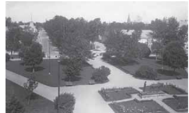
Cygnaeuksenpuiston käytäväverkkoa uusitaan vanhan mallin mukaisesti. Kuvattu 1920-luvulla, Satakunnan Museon arkistot
