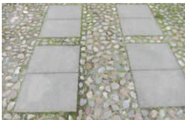
Enkel belægning med beton og traditionelle pigsten
