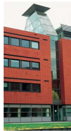
Afb. 22: Zonneschoorsteen Dit kantoorgebouw op het Céramique-terrein in Maastricht bestaat uit een aantal bouwblokken rondom een atrium. Het gebouw is voorzien van vier glazen 'zonneshoorstenen' die zorgen voor extra natuurlijke trek voor het natuurlijke ventilatiesysteem. Ontwerp: Hubert-Jan Henket, Henket & Partners te Esch. Realisatie 2000. Ook in het Sportcomplex De Vlinder in Wageningen is een zonneshoorsteen toegepast.
