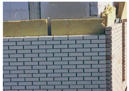
Afb. 27: Een zeer zorgvuldige uitvoering is gewenst. Zo dient de isolatie in de spouw goed aan te sluiten op het binnenspouwblad. Bovendien moeten de isolatieplaten goed op elkaar aansluiten.
