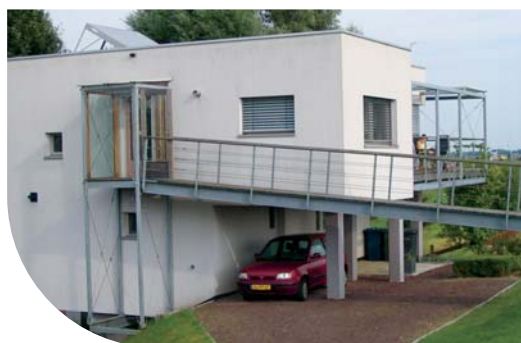
Afb. 21: Vrijstaand 'passief huis' in Dalem. Belangrijke kenmerken: Zeer goed geïsoleerd (Rc-waarden van 8 m 2 K/W voor gevels, dak en begane grondvloer), passieve zonne-energie met buitenzonwering, zonneboilercombi, gebalanceerde ventilatie met wtW met bypass en voorverwarming en koeling via bodem-warmtewisselaars. Gemeten gasverbruik voor ruimte- en tapwaterverwarming: circa 650 m 3 gas per jaar. Ontwerp: Franke Architecten te Sliedrecht. Realisatie: 2000 (lit. 11).
