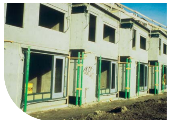
Afb. 33: 100% puigranulaat in het project 'Delftse Zoom in Delft'. In de circa 270 woningen werd voor een aantal prefab betonnen onderdelen het grind volledig vervangen door menggranulaat. Dit mengsel bestaat uit minstens 50% betongranulaat. Architecten: Inbo Architecten, Architectenbureau Galis en Baneke - Van der Hoeven Architecten. Realisatie: 1998.
