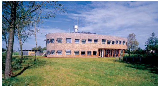
Afb. 5: Kantoorgebouw Rijkswaterstaat in Terneuzen. Zowel bouwkundig als installatietechnisch zijn veel bijzondere maatregelen toegepast zoals de natuurlijke ventilatie en de shingels van afgedankte meerpalen voor de gevelbekleding. Architect: Bureau opMAAT. Realisatie: 2000.
