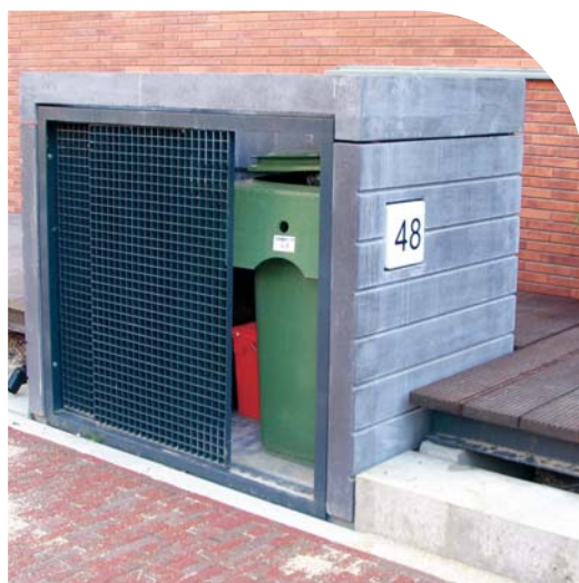
Afb. 36: In de architectuur meegenomen opstelvoorziening voor minicontainers in woningbouwproject in de wijk Roomburg te Leiden.
