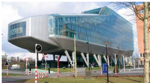
Afb. 6: Hoofdkantoor ING in Amsterdam met veel daglicht door veel glas, klimaatgevel en diverse binnentuinen. Architecten: Meyer en Van Schooten; realisatie: 2002.
