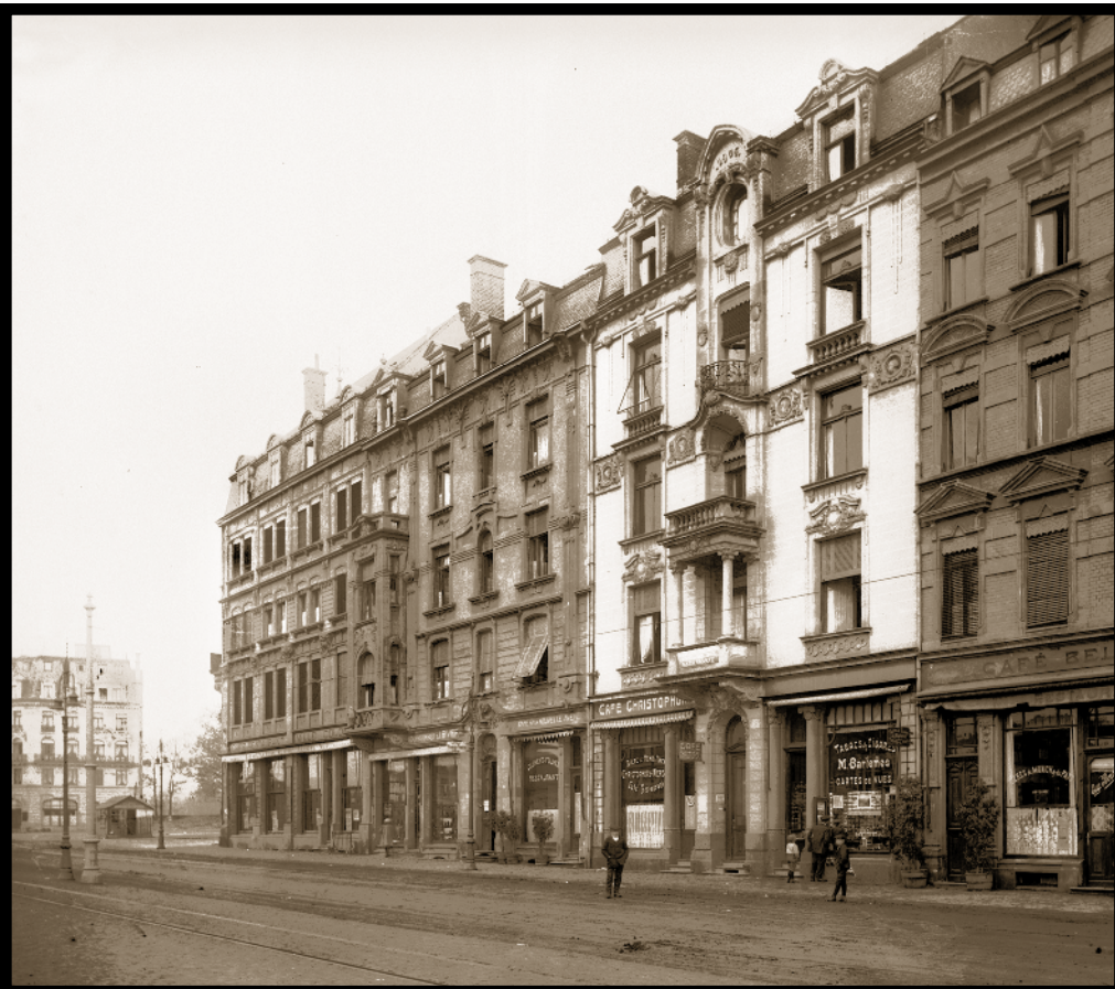
Häuserzeile, an der Place de Paris und Nr. 41, Avenue de la Liberté
