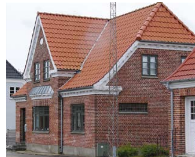
Bedre Byggeskik-huse langs hovedgaden
