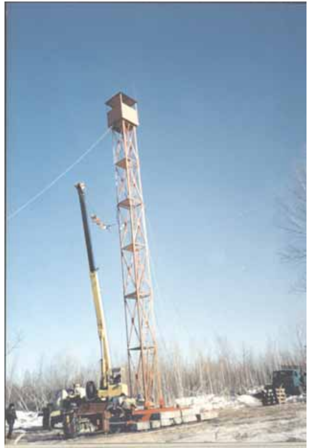
Установка пожарно-наблюдательной вышки
