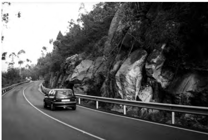
COSTA DE MOIMENTA: ROCHAS AMEAZANTES SOBRE O VIAL. SINAIS PROVISIONAIS E PASO ESTREITO. ATENTOS Á LEI DE MURPHY.
