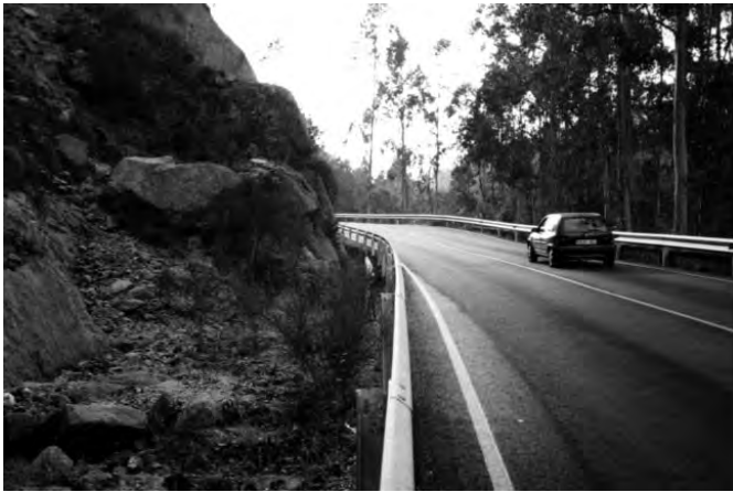
COSTA DE MOIMENTA. ROCHAS DESPRENDIDAS DA LADEIRA INESTABLE DO MONTE
