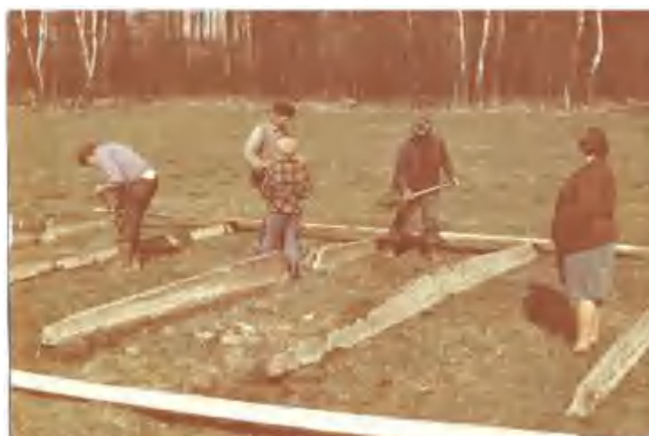
Prace przy budowie kaplicy
