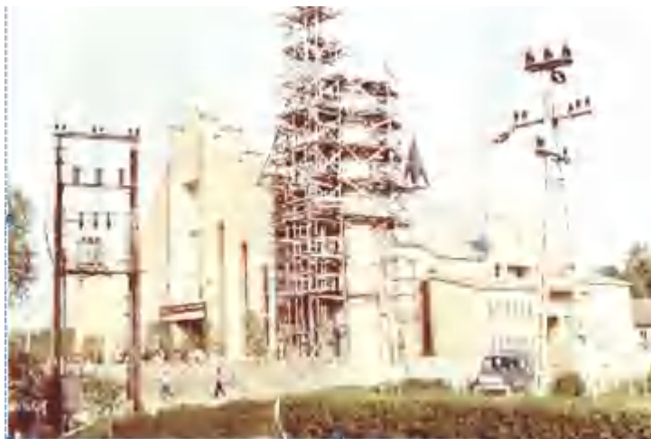
Zakończenie budowy wieży kościoła pw. NMP Matki Miłosierdzia w Szepietowie, 1985 rok.
