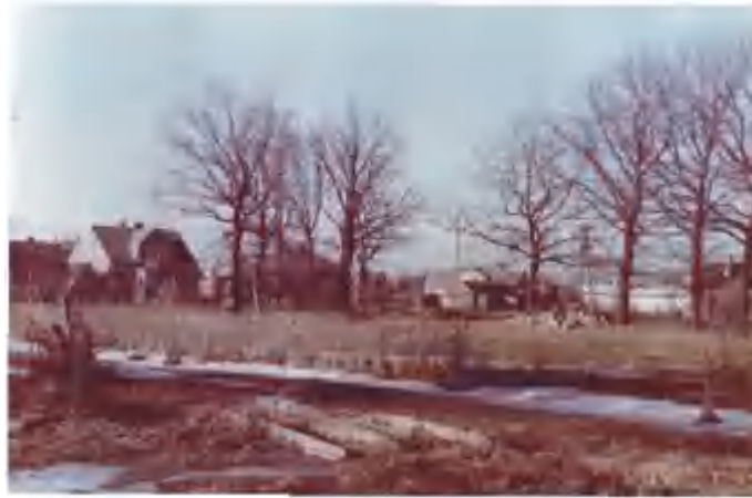
Plac pod budowę świątyni
