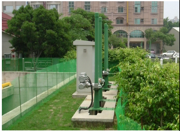
照片 7 調節池閘門
