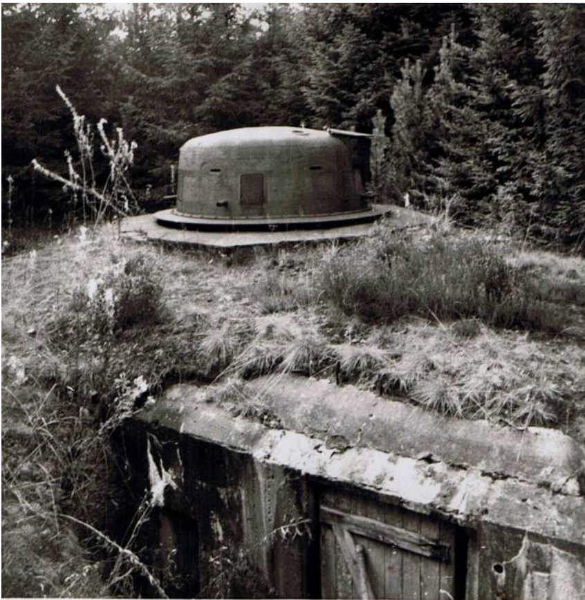
Bunker type XII monteret med et pansertårn, som var beregnet til montering af en 20 mm maskinkanon. (foto N.M. Schaiffel-Nielsen, 1974).
