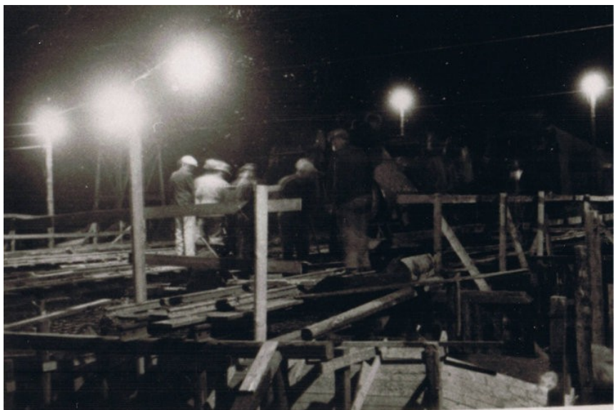
Tyskerne havde så travlt med at få Stützpunkt Vandel gjort operationsklar, at støbningen af bunkerne foregik i døgndrift. Billedet er taget af Stellvertretende Baurat Hermann Süling.
