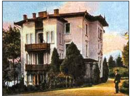
Свято-Михайловская церковь в Герберсдорфе, перестроенная в коттедж
