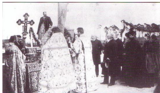
Закладка камня под фундамент «Александр хайма»
