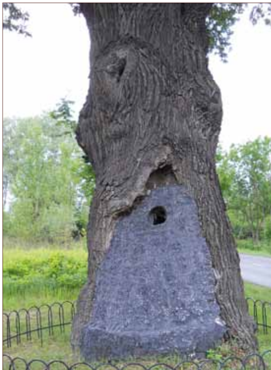
Ryc. 38. Jeszcze nie tak dawno temu powszechna była praktyka „leczenia” drzew dziuplastych poprzez usuwanie murszu i zalewanie dziupli betonem. Dąb Bartek – najokazalsze drzewo pomnikowe w Bydgoszczy. Fot. AO.
