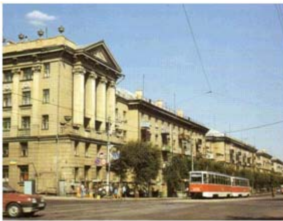
Рис. 26. Фасады жилого дома по ул. Ленинградская (северная часть)
