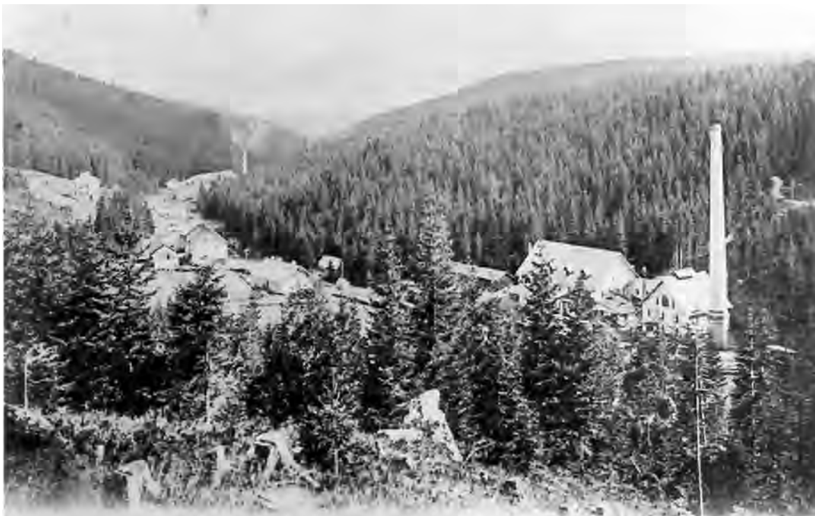
Obrázek 5. Papírna na Františkově. V pravé části obrázku je dobře vidět celá horní továrna i s továrním komínem. Foto Josef Seidl r. 1916
