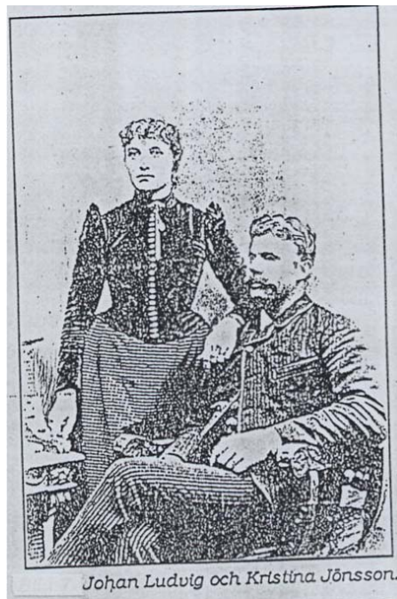
25. Bonden Johan Ludvig Jönsson med hustru etablerade Rya tegelbruk.
