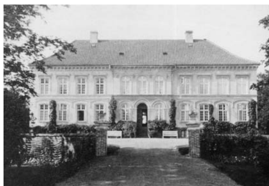
14. Rydebäcks Gård med den ursprungliga vackra gjutjärntrappan
