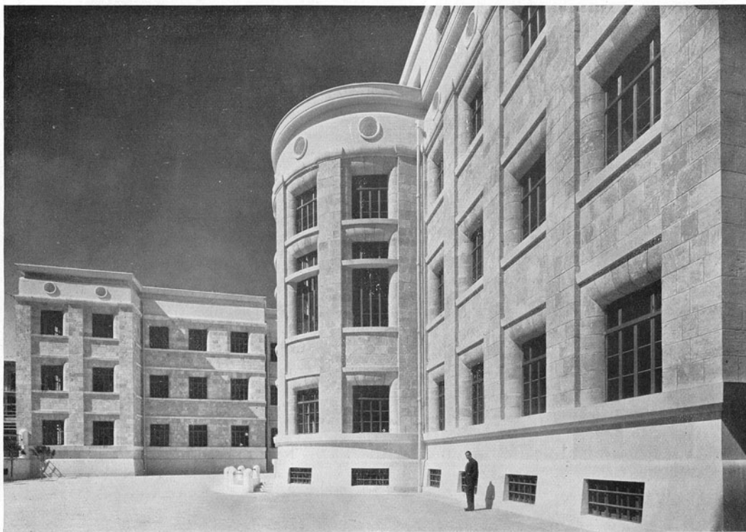
ARCH. CONCEZIO PETRUCCI. - LICEO E GINNASIO A BARI. - IL CORTILE CON LA TRIBUNA DELL'AULA MAGNA.
