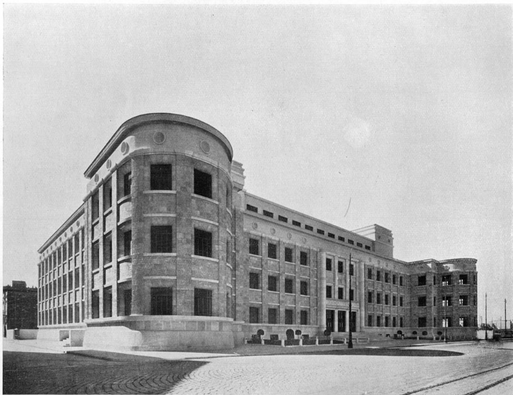
ARCH. CONCEZIO PETRUCCI. - LICEO E GINNASIO A BARI. - VEDUTA PROSPETTICA DAL LUNGOMARE (CORSO TRIESTE).
