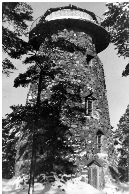
Foto 29: Talveks kaeti torn ajutise katusega.
