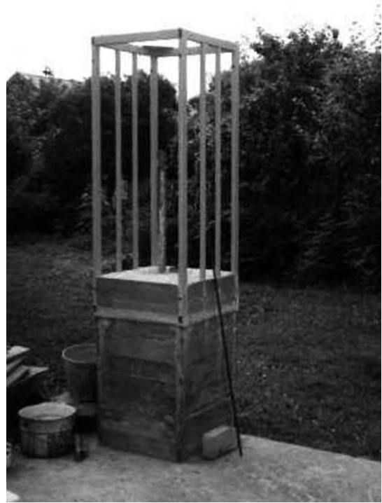
Foto 74: Seoses remondiga Tallinna Tähetornis rajatud ajutise robotobservaatoriumi "0-tsükkel".
