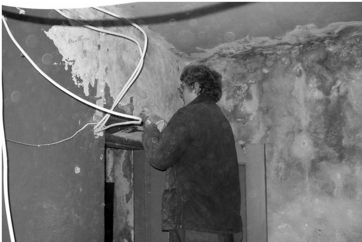
Foto 69: Peaaegu omavoliline remont fuaees (vaade 1).
