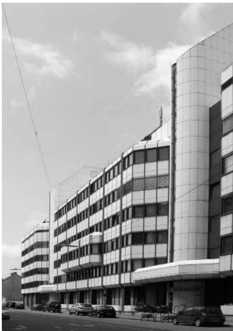
Budova hlavního sídla Rakouského státního archivu v Nottendorfer Gasse
