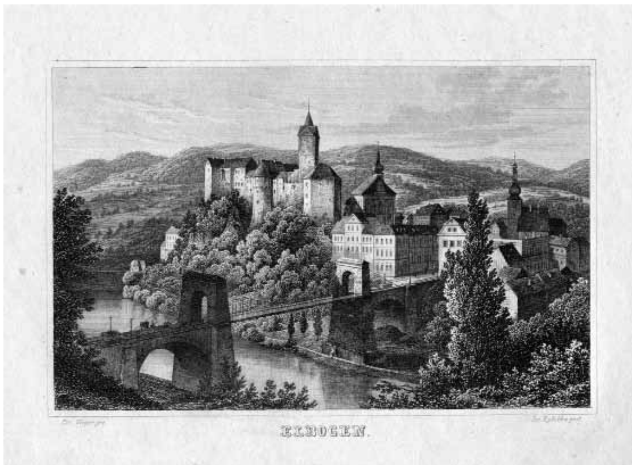
Řetězový most přes řeku Ohři s impozantním panoramatem hradu a části města Loket. E. Unger, kolem 1850
