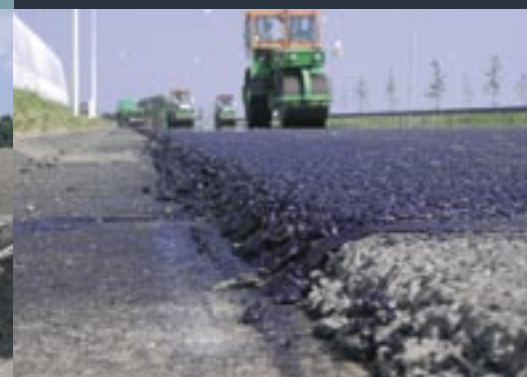
Augustus 2005: De toplaag ZOAB is in grote delen aaneengesloten aangebracht, wat een positief effect heeft op het onderhoud.
