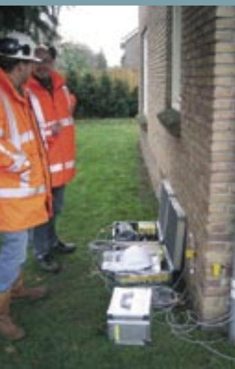
December 2003: Tijdens het heien bij Maliskamp worden metingen verricht om te bepalen of de trillingen binnen de normen blijven.
