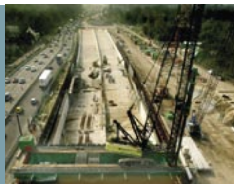
September 2004: Zicht in westelijke richting op de verdiepte ligging bij Maliskamp.
