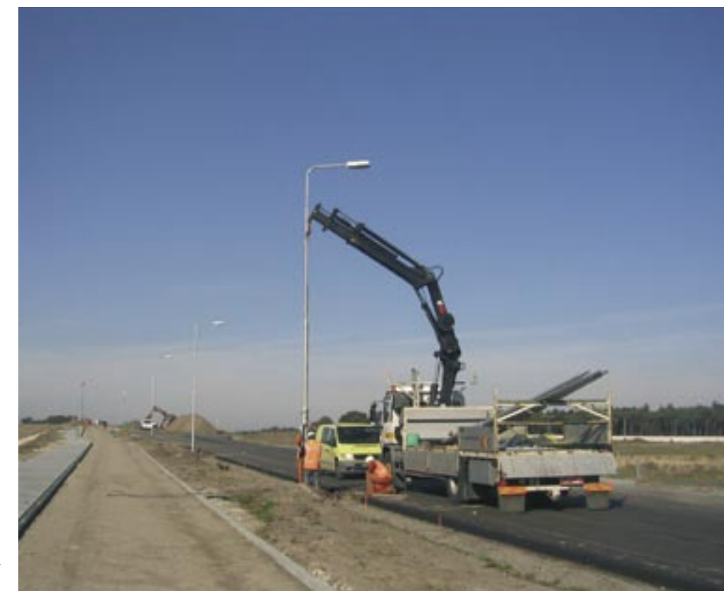
Oktober 2005: Aanbrengen van verlichting op de Vliertwijksestraat nabij viaduct.
