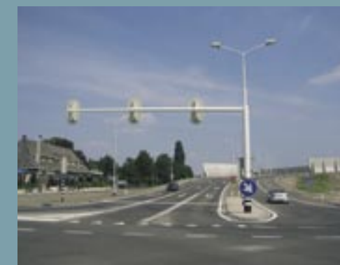
Augustus 2004: Zicht op de nieuwe noordelijke toe- en afrit A59 bij Rosmalen.
