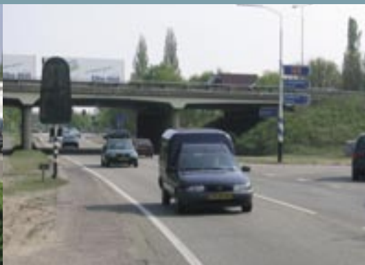
Juli 2003: Berlicumseweg ter hoogte van viaduct 'Stenenkamer', oude situatie noordzijde.
