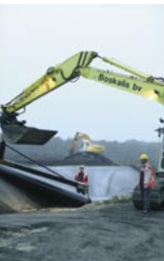
September 2004: Folie wordt gelegd om het grondwater te beschermen.
