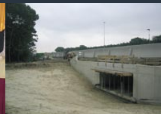
Juli 2004: Zicht op de noordelijke inloop van de wildtunnel onder de toekomstige A59. Dankzij de glooiende komvorm kunnen de dieren straks gemakkelijk de tunnel in lopen. De tunnel is 8 bij 2,5 meter en is 70 meter lang.
