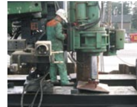
December 2003: Plaatsen van vibro combinatiepalen voor de waterkelder, het diepste punt van de verdiepte ligging van de A59 bij Maliskamp.
