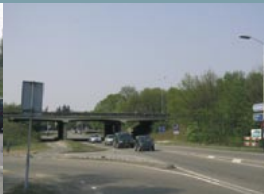
Juli 2003: Berlicumseweg ter hoogte van viaduct 'Stenenkamer', oude situatie zuidzijde.
