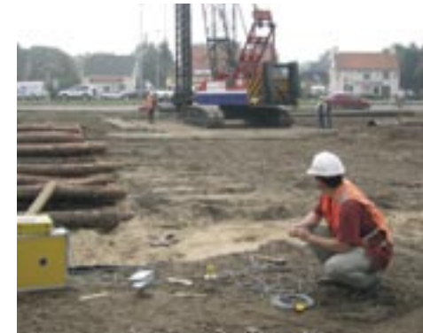
Oktober 2003: Bij Maliskamp wordt met beulp van meetapparatuur het effect op de omgeving van de proeven met de damwand en heipaal in kaart gebracht.
