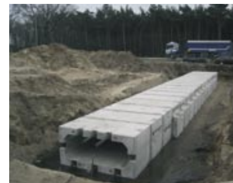
April 2004: Aanleg van een faunapassage tussen Maliskamp en de Vliertwijksestraat.
