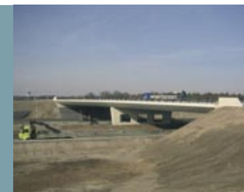
Maart 2005: Het nieuwe viaduct Duinsche Hoef bij het Autotron.
