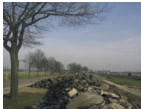
Februari 2005: Het asfalt van de oude rijksweg tussen Nuland en Geffen is opgebroken.
