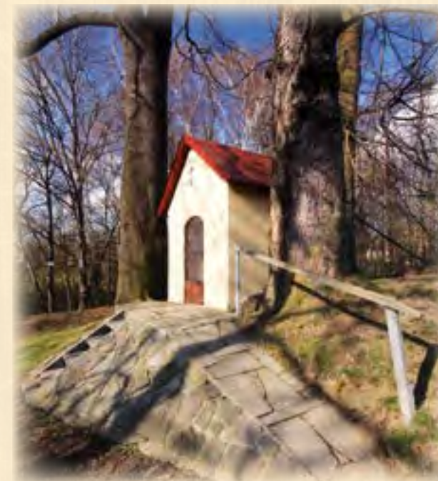
Kaple Panny Marie (původně sv. Trojice) na Vinohradě, 4. dubna 2010
