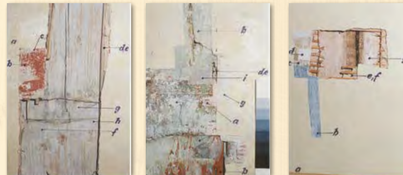
Sondy restaurátorského průzkumu výmalby interiéru řepišťského kostela, r. 1996
