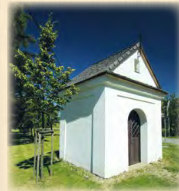
Kaple sv. Floriána na ul. Zemědělské, 3. července 2010
