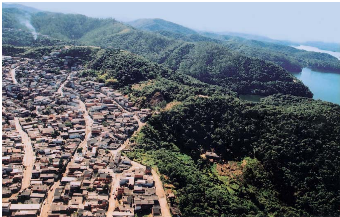
Figura 1.3.2 - Ocupação irregular em áreas de interesse ambiental – Represa Billings. Crédito:Acervo/SMA
