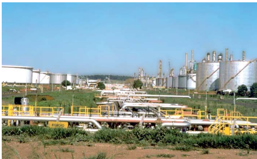
Figura 3.1.3 Refinaria de Paulínia
