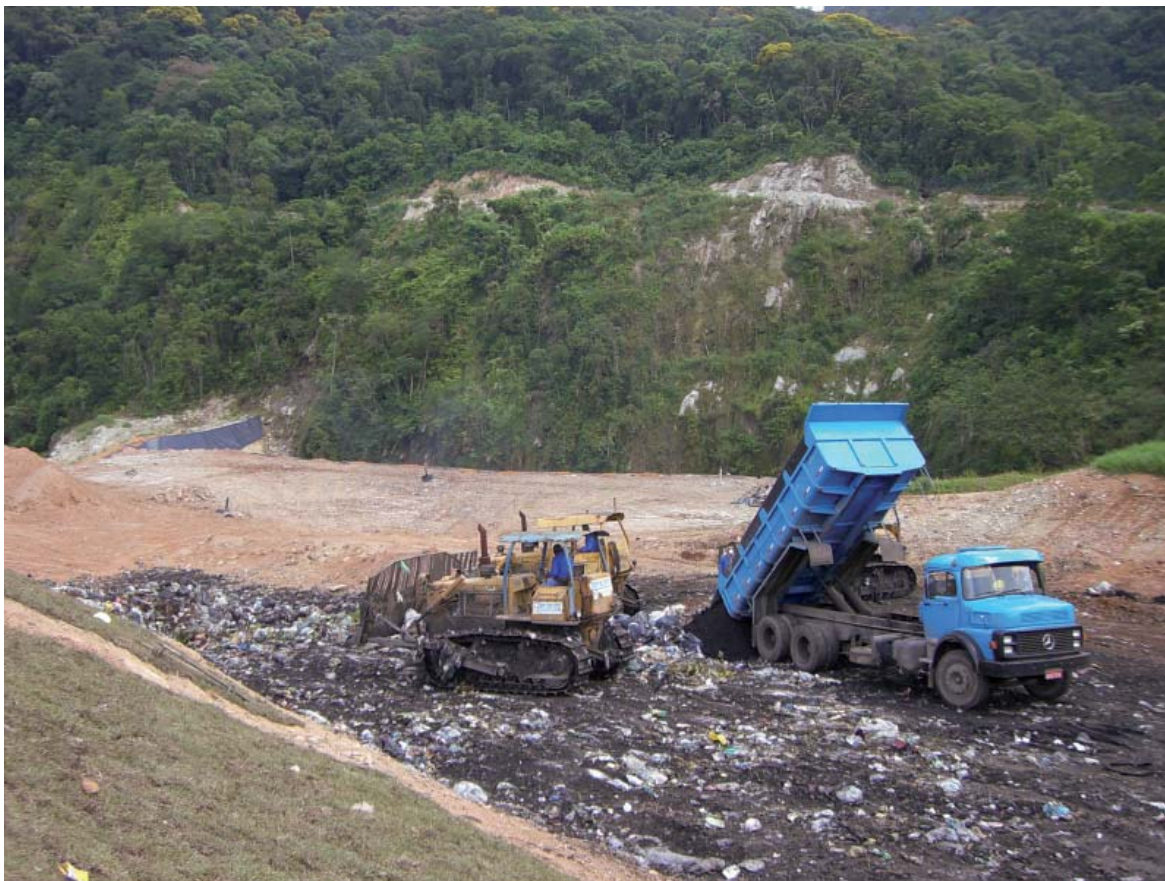
Figura 3.3.3 - Rotina de trabalho em um aterro dentro das normas de controle ambiental. Crédito:Acervo/SMA
