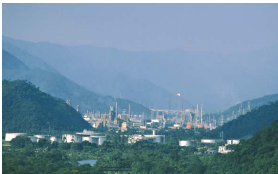
Figura 1.1.1 - Exploração de Petróleo no Brasil: Refinaria Presidente Bernardes, na Cidade de Cubatão, Baixada Santista.
