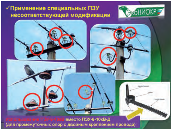
Рис. 10. Применение ПЗУ-6-10 кВ вместо ПЗУ-6-10 кВ-Д.
