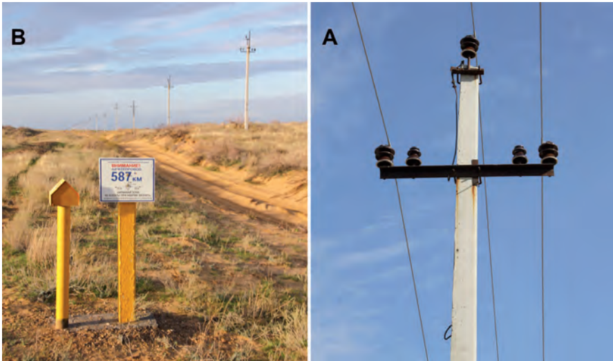
Рис. 3. А – оголовок опоры ВЛ «Газпром трансгаз Ставрополь» (трубопровод «Магат – Северный Кавказ»), В – ВЛ катодной защиты трубопровода АО КТК. Астраханская область РФ, 11.10.2011. Фото М. Пестова.
