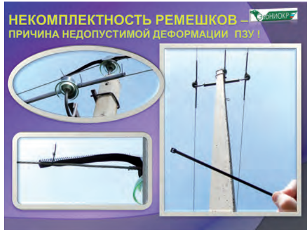
Рис. 12. Некомплектность крепежного бандажа.
