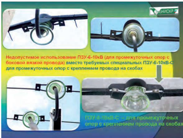
Рис. 11. Применение ПЗУ-6-10 кВ вместо ПЗУ-6-10 кВ-С.
