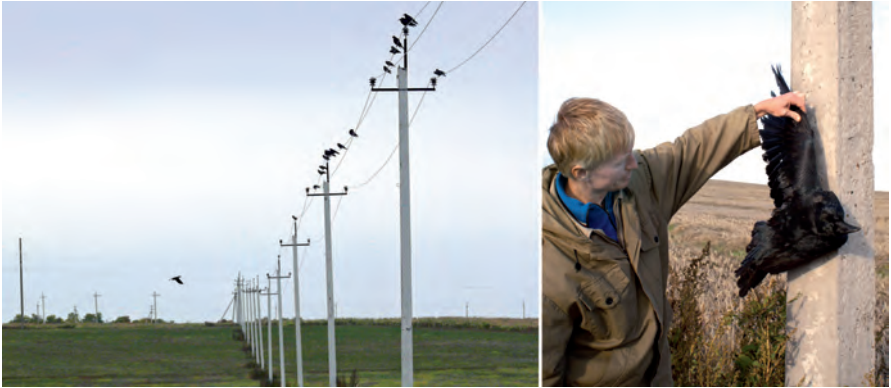
Врановые после вылета в массу концентрируются на опорах и проводах птицепоисных ЛЭП, где и погибают. Фото Р. Бекмансурова и Д. Жукова.
