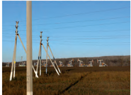
Птицепасные ЛЭП, подающие электроэнергию на автозаправочные станции (вверху), вышки сотовой связи (в центре), объекты нефтедобычи (внизу).
