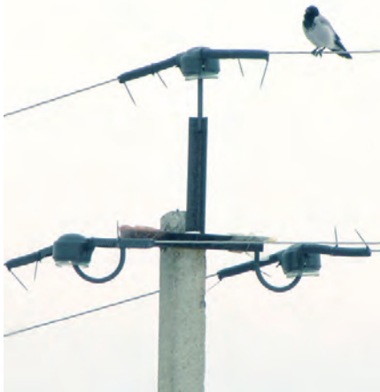
ПЗУ российского производства решают проблему гибели птиц от электротока. Фото И. Карякина.
