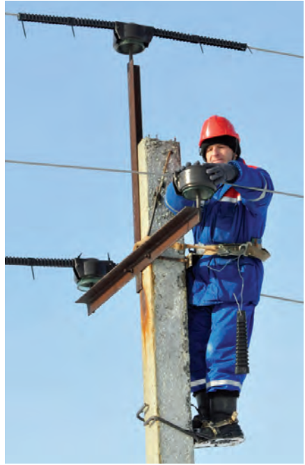
Установка птицевегащительных устройств на ЛЭП в Алтайском крае. 23.11.2010. Фото А. Грибкова.
