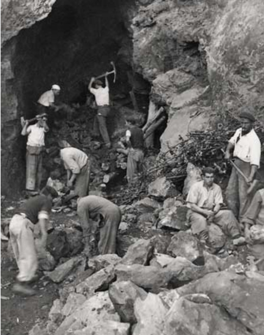
LANGILEAK TUNEL BATEN ZULAKETAN LANETAN. BUESA FAMILIAREN ARTXIBATEGIA. OBREROS TRABAJANDO EN LA PERFORACIÓN DE UN TÚNEL. ARCHIVO FAMILIA BUESA.
