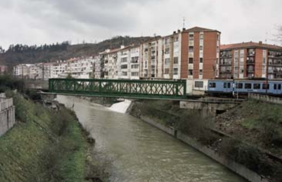
IBAIZABAL IBAIAREN GAINEKO ZUBIA, ZORNOTZAN. BERTAN ARGÍ ETA GARBI IKUSTEN DIRA IRTENDA DAUDEN ORMIGOI ARMATUZKO ESTRIBOAK, GERRA ZIBILEAN ERAIKITAKOAK. ARGAZKIA, JUANJO OLAIZOLA. PUENTE SOBRE EL IBAIZABAL EN AMOREBIETA EN EL QUE SE APRECIAN CON CLARIDAD LOS ESTRIBOS DE HORMIGÓN ARMADO EN VOLADIZO CONSTRUIDOS DURANTE LA GUERRA CIVIL. FOTO, JUANJO OLAIZOLA.
