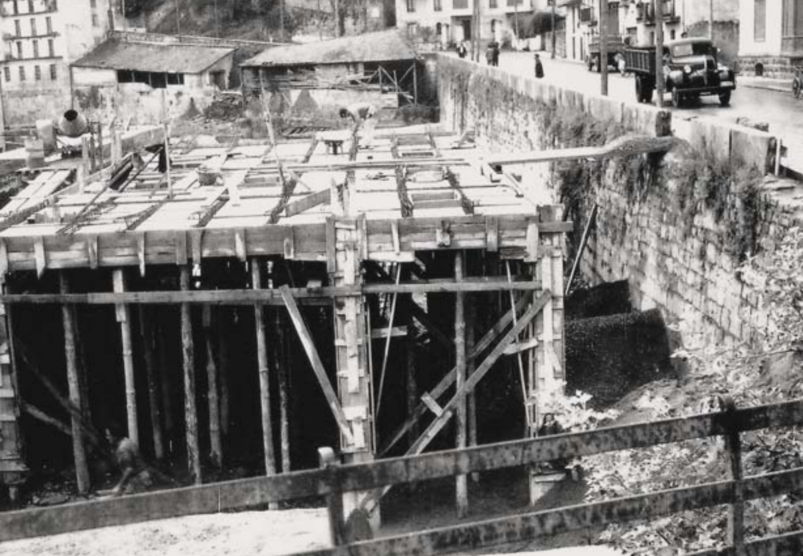
BERMEOKO GELTOKIKO EGITURAREN ENKOPRATUA. EUSKO TRENEAN ARTXIBATEGIA. ENCORRADO DE LA ESTRUCTURA DE LA ESTACIÓN DE BERMEO. ARCHIVO EUSKO TREN.
