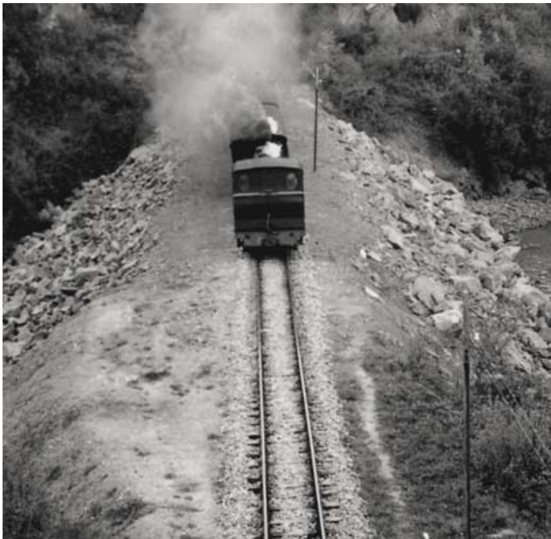
BERMEOKO LUZAPENA TRENBIDEA BEHAR BEZALA OINARRITU GABE INAUGURATU ZEN, ETA, ONDORIOZ, URTE LUZEZ ABIADURAK MUGA HANDIAK IZAN ZITUEN. SANTIAGO AGUIRRESAROBAREN ARTXIBATEGIA. LA INAUGURACIÓN DE LA PROLONGACIÓN A BERMEO SE REALIZÓ SIN ASENTAR DEBIDAMENTE LA VÍA, LO QUE OBLIGÓ A MANTENER IMPORTANTES LIMITACIONES DE VELOCIDAD DURANTE VARIOS AÑOS. ARCHIVO DE SANTIAGO AGUIRRESAROBE.
