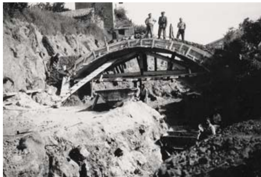
BERMEORAKO LUZAPENEN LANEN ITXAROPEN HANDIAK SORTU ZITUZTEN. EUSKO TRENEAN ARTXIBATEGIA. LAS OBRAS DE PROLONGACIÓN A BERMEO GENERARON GRANDES ESPERATIVAS. ARCHIVO EUSKO TRENEAN
