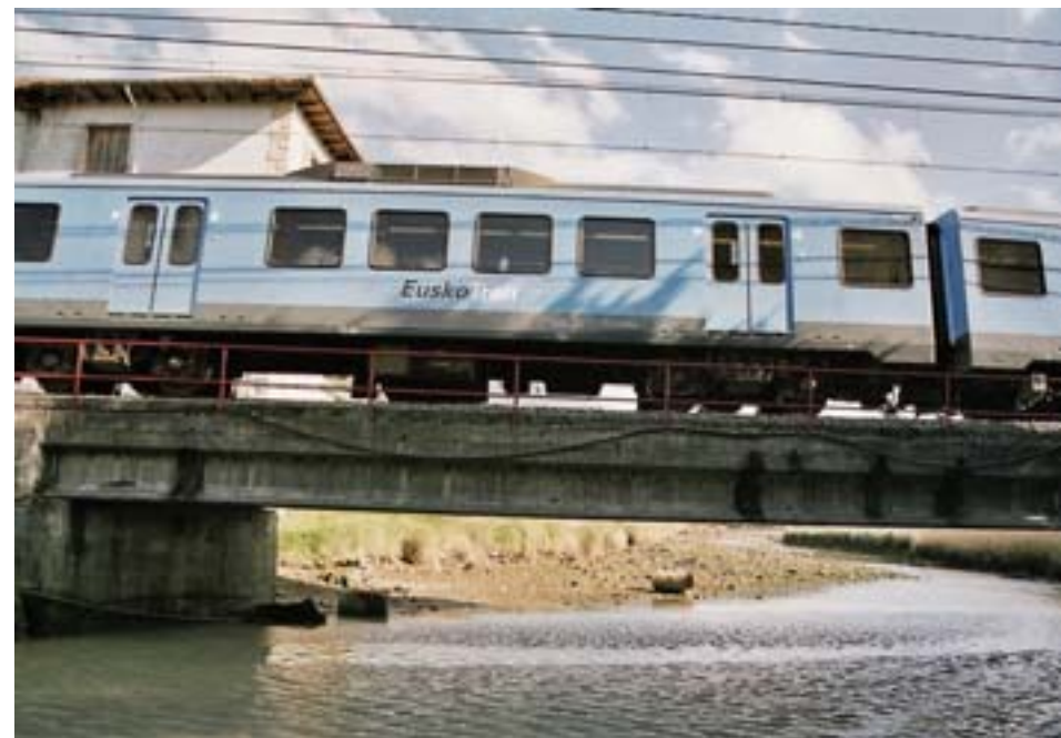
GAUR EGUN, SAN KRISTOBALGO ZUBIA ORMIGOI ARMATUZKO HABEEK OSATZEN DUTE. ARGAZKIA, JUANJO OLAIZOLA EN LA ACTUALIDAD, EL PUENTE DE SAN CRISTOBAL ESTA FORMADO POR VIGAS DE HORMIGÓN ARMADO. FOTO, JUANJO OLAIZOLA
