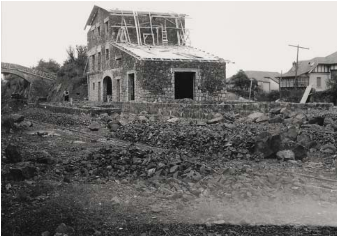
MUNDAKAKO GELTOKIAREN ERAIKUNTZA LANAK. EUSKO TRENEAN ARTXIBATEGIA. OBRAS DE CONSTRUCCIÓN DE LA ESTACIÓN DE MUNDACA. ARCHIVO EUSKO TREAN.
