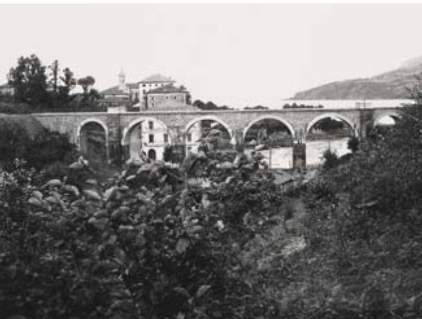
MUNDAKAKO BIDEZUBIAREN IKUSPEGIA, BERMEOKO LUZAPENEO LANAK BURUTZEN ARI ZIRELA. EUSKO TRENEAN ARTXIBATEGIA. VISTA DEL VIADUCTO DE MUNDACA DURANTE LA CONSTRUCCIÓN DE LA PROLONGACIÓN A BERMEO. ARCHIVO EUSKO TREAN.
