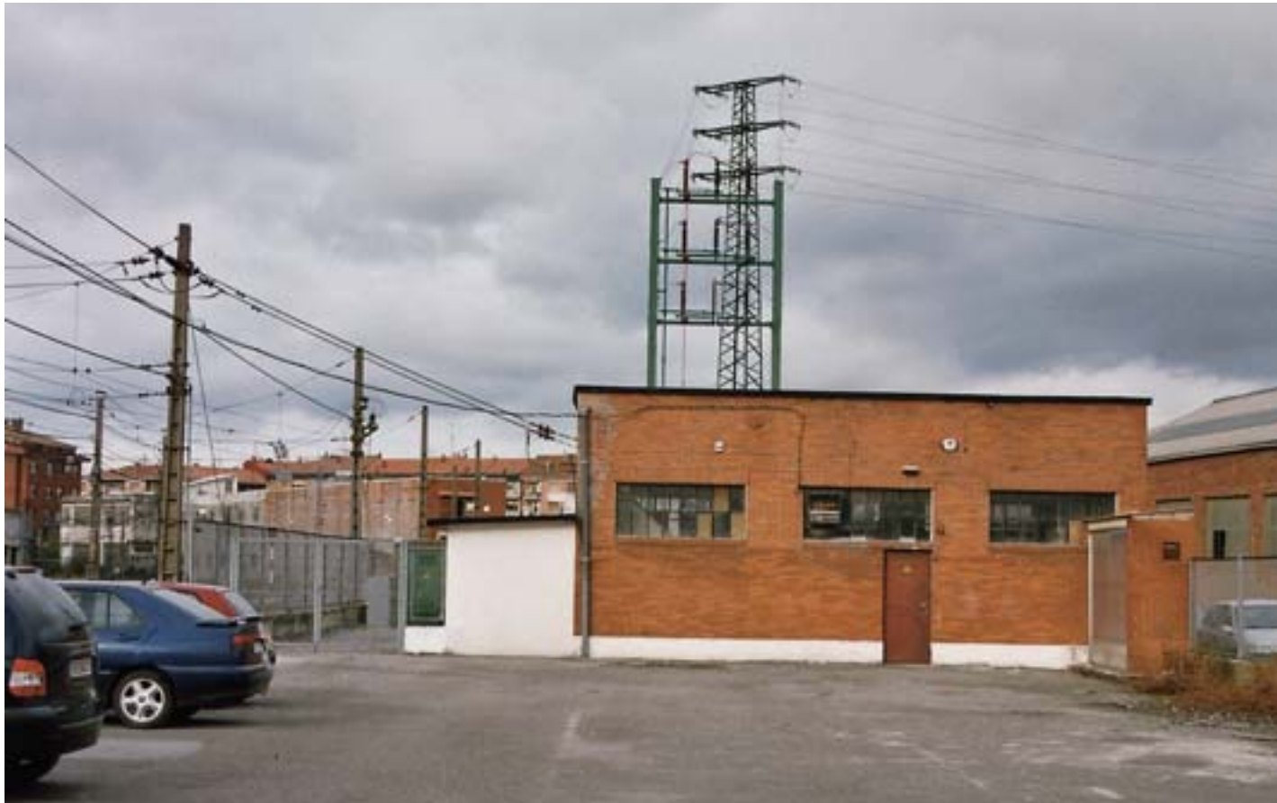
GERNIKAKO TRAKZIO AZPI-ESTAZIOKO GELTOKIA. ARGAZKIA, JUANJO OLAIZOLA. EDIFICIO DE LA SUBESTACIÓN DE TRACCIÓN DE GUERNICA. FOTO, JUANJO OLAIZOLA.
