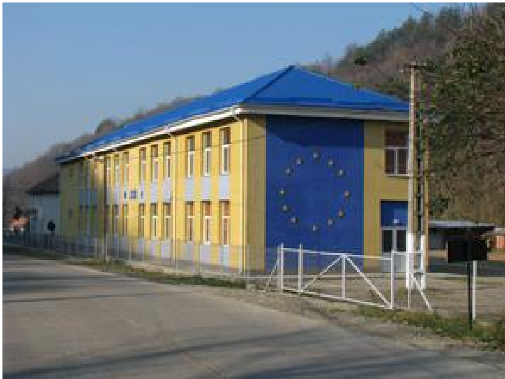
F.8.4.25 Școala nouă, 1975 (modernizată după 2004).
