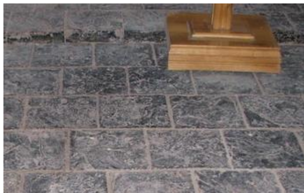
Pardoseal (bis) din placi de turn torie.
