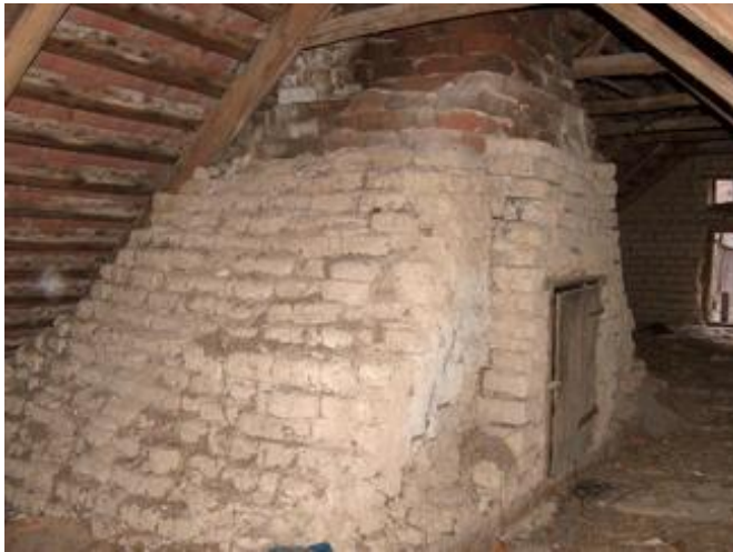
F.3.95 Horn deschis la o cas din Vârâ i (vedere din pod i în interior), 2006
