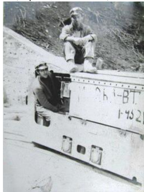
F.8.1.86 Idem F.8.1.87 Mecanici (Radu Pârveu i Puiu Tofan) pe locomotiva electric cu acumulatori, tip LAM 4, IPEG, sector Remetea, gal.375, cca.1980 (Colec ia V. T utu)
