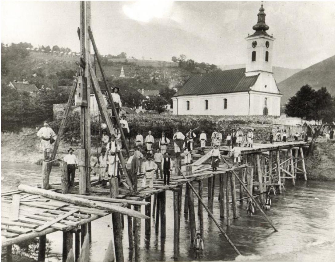
F.1.3 Construirea unui nou pod de lemn peste Nera după marea inundație din mai-iunie 1910, foto 1910 (Colecția V.T. Uțu) Înscris pe marginea foto: „Au început ploaia la Duduți și Sara la 5 Ciasuri și au intrat până noaptea la 12 Ciasuri Neconținute și au fost Merganu până la Casa lui Niș Gropănu Atuncia au ruptu Podu și Oameni Au Omorât și Marv mult și Luncile au fost toate pline cu apă Saszkabanya în 31 Maiu 13 Iunie 1910 Vasile Petru jurat la Komun ”
