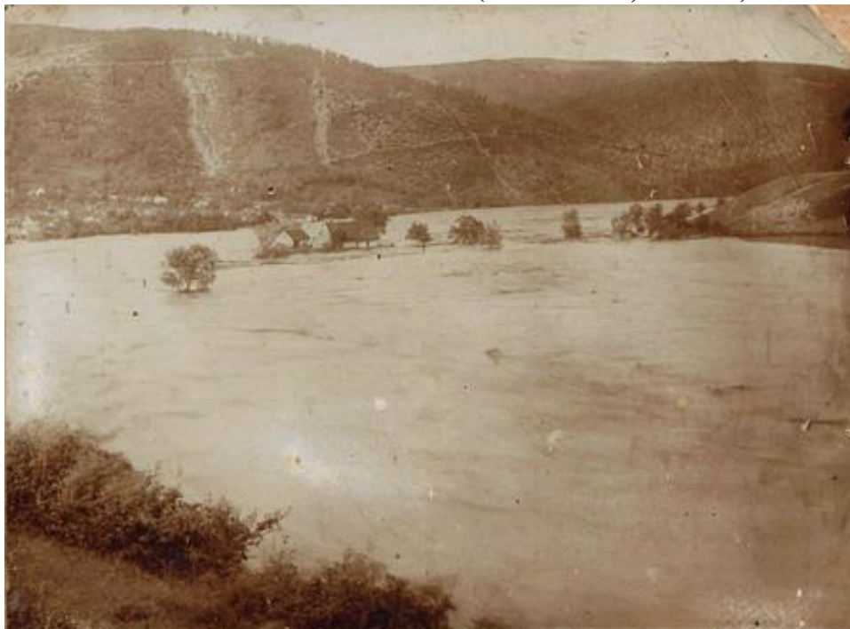
F.1.2 Marea inundație a râului Nera, foto 14 iunie 1910 (Colecția V. T. utu)
