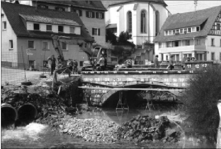
Bild 30-1: Die „Zolleisenbrücke“ sollte in der gleichen Art wieder aufgebaut werden. Die alten Sandsteine wurden darum einzeln nummeriert. Ein großer Teil ging jedoch beim Abtragen zu Bruch und konnte somit nicht wiederverwendet werden.
