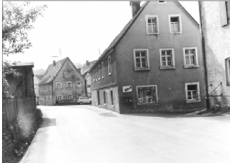
Foto 24-1: Das „Saalers-Eck“ vor der Sanierung, 1970
