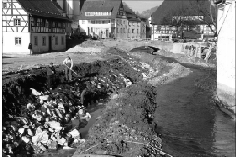
Foto 31-1: Die Sanierung des Bachbettes im Bereich der „Zolleisenbrücke“
