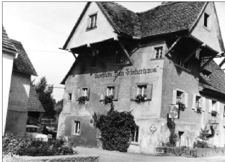
Foto 23-1: Das ehemalige Färberhaus
