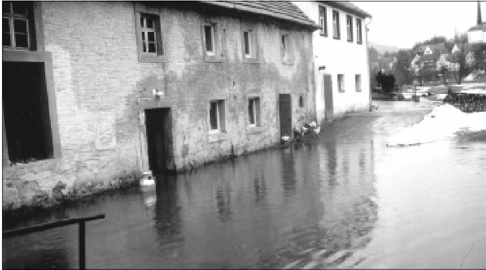
Foto 29-1: Überschwemmung durch die Leinleiter im Ortskern von Heiligenstadt (Foto: Wasserwirtschaftsamt Bamberg)
