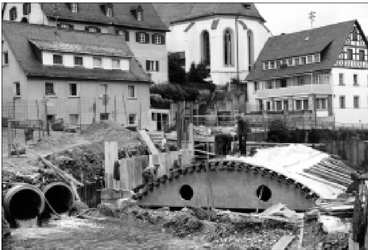
Foto 30-2: Die Sanierung der „Zolleisenbrücke“.
