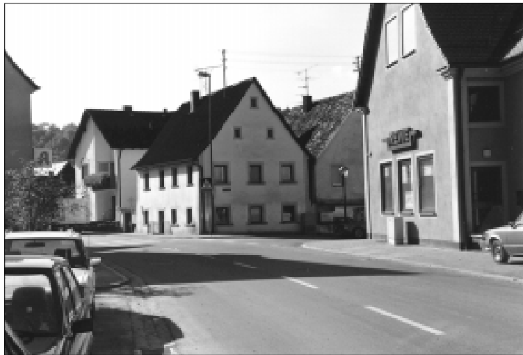
Foto 24-2: Das „Saalers-Eck“ nach der Sanierung, 1984
