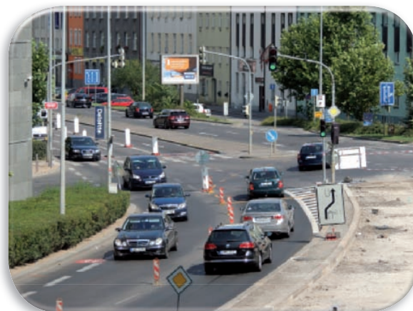
Rekonstrukce části Rohanského nábřeží
