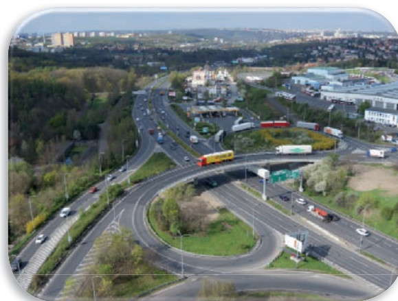
Most Ke garážím přes Jižní spojku
