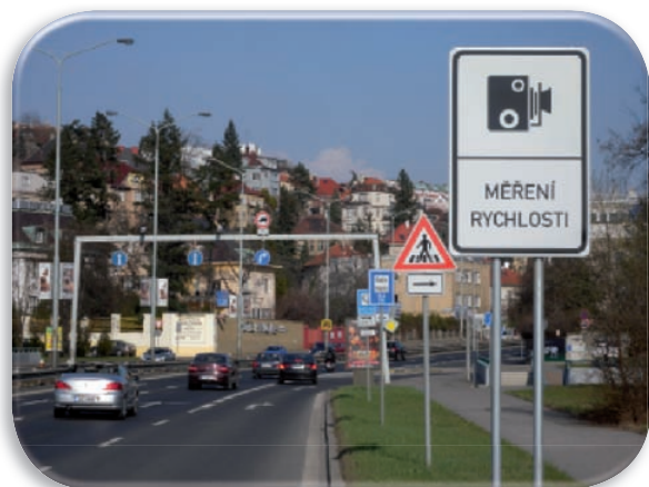
Úsekové měření rychlosti v ulici V Holešovičkách
