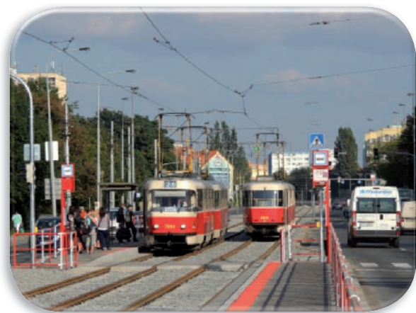
Zrekonstruovaná zastávka Na Groši
