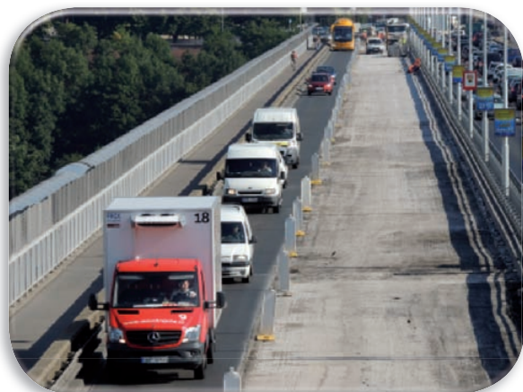
Oprava krytu vozovky na části Nuselského mostu
