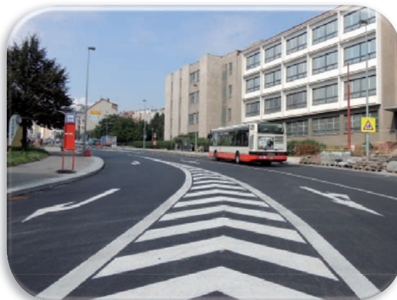
Nový povrch vozovky v Kodaňské ulici
