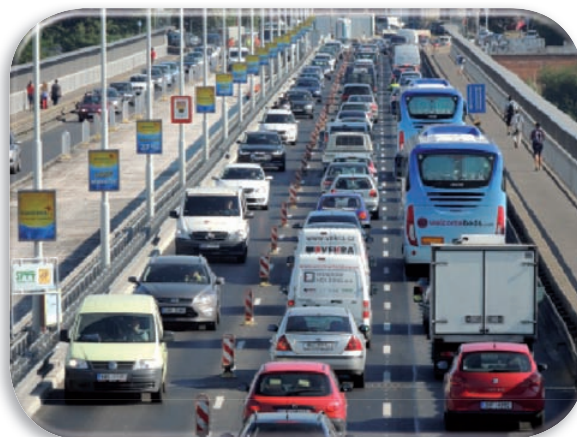
Provoz na Nuselském mostě v době jeho opravy
