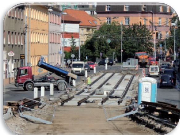
Rekonstrukce tratě v Průběžné ulici
