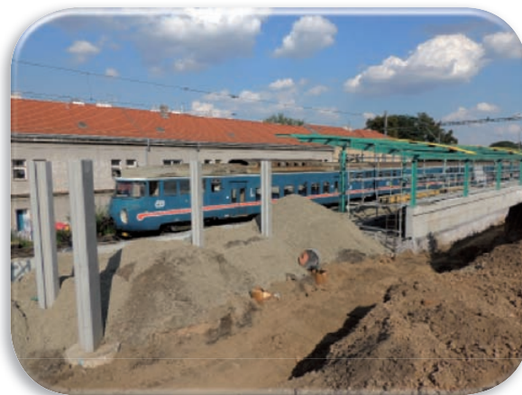
Výstavba zastávky Praha-Podbaba
