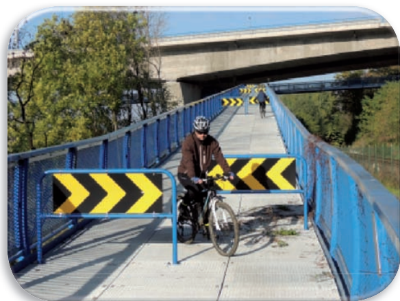
Nájezdová rampa na lávku pod Pražským okruhem
