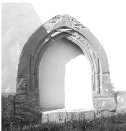
3. A templom déli csúcsíves homokkőből készült befalazott ajtókerete.
