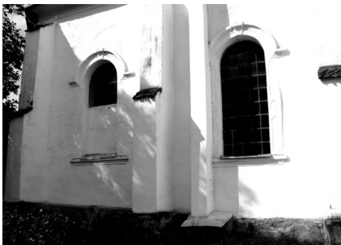
2. A templom déli homlokzatának kétlépcsős támpillérei és ablakai
