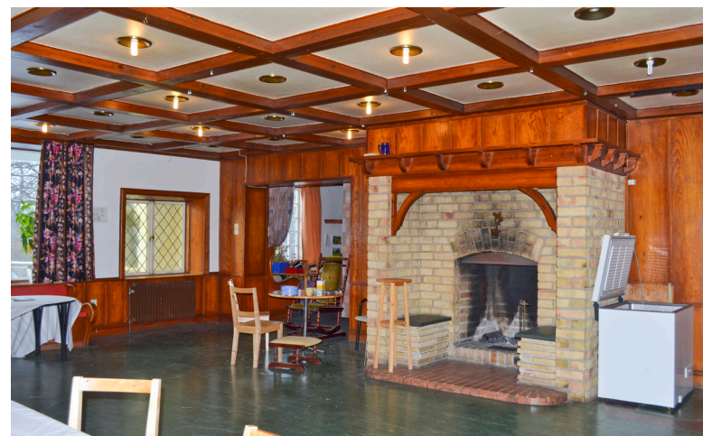
Den stora hallen på souterrängvåningen. Bjälktak, paneler, perspektivfönster, blyspröjs och golvet vinylhartsmattor har tillkommit i efterhand, troligtvis vid 1950-talets slut. Den stora spisen har ursprungligt läge men har byggts ut med gult tegel. Under vinylhartsmattorna ligger ett rejält och vackert kalkstensgolvet som kan var ursprungligt.
