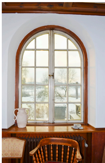
Ursprungliga rundbågade fönstersnickerier vetter in mot den lilla hallen.
