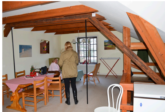
Här en del av det stora rum som ligger på vindens mitt. Till höger angör vindstrappan. Alla fönstersnickerier på vinden (förutom i den oinredda delen) är sentida men fint anpassade till de ursprungliga.
