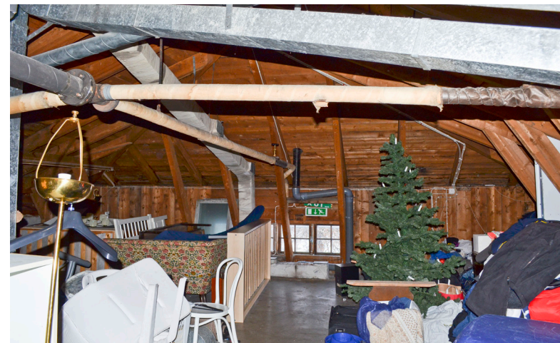
Den oinredda delen av vinden med fönster ut mot väster.
