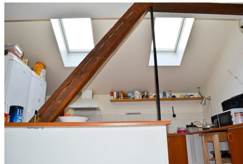
Vindens kök. I takfallet de två sentida takfönstren mot söder.
