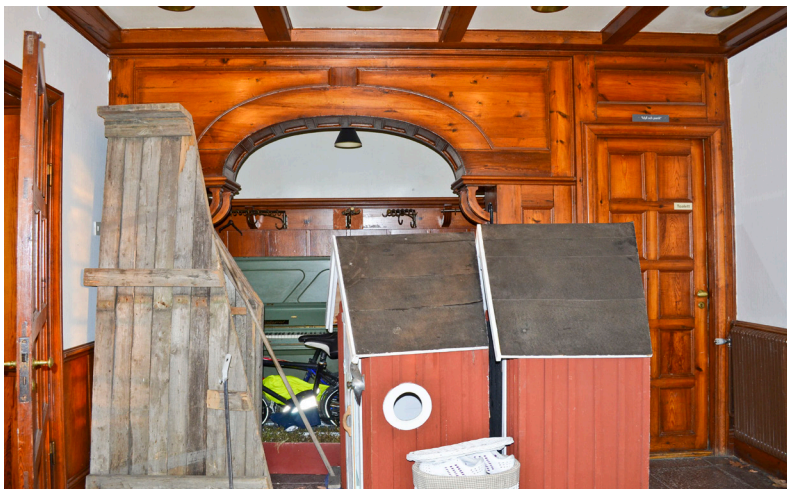
I huvudentréns mindre hall finns ursprunglig fast inredning som ramar in det fina lilla kapprummet. Här ligger samma kalkstengolv som i den stora hallen.
