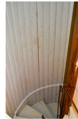
Tjänstefolkets trappa med ursprunglig konstruktion och inredning av trä.
