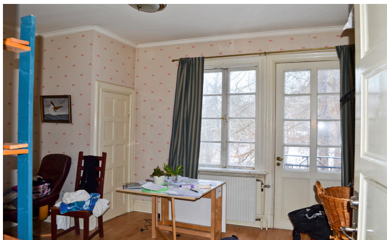
Här det lilla sovrum som vetter ut mot den västra sidans ursprungliga balkong. Den glasade balkongdörren är ursprunglig och med tidstypisk sluten bröstning i samma höjd som fönstret intill. På ritningen markerat som "Doris rum".
