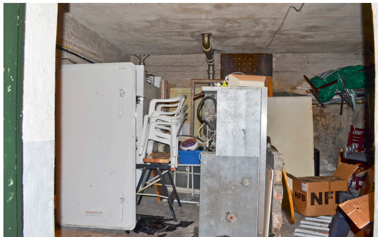
Källaren består av flera förvaringsrum, pannrum, vedrum och matkällare. Källarens väggar och bjälklag tycks vara gjutna av betong.
