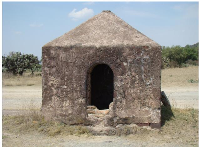
Fig. 8 Una vista del caño del acueducto y de una caja de agua
