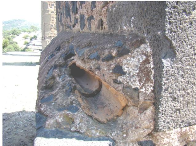
Fig. 2 Tubería de barro en los pilares
