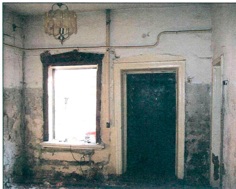
Фрагмент интерьера. Фото 2012г.
