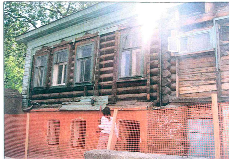
Общий вид после снятия обшивки. Боковой фасад. Фото 2012г.
