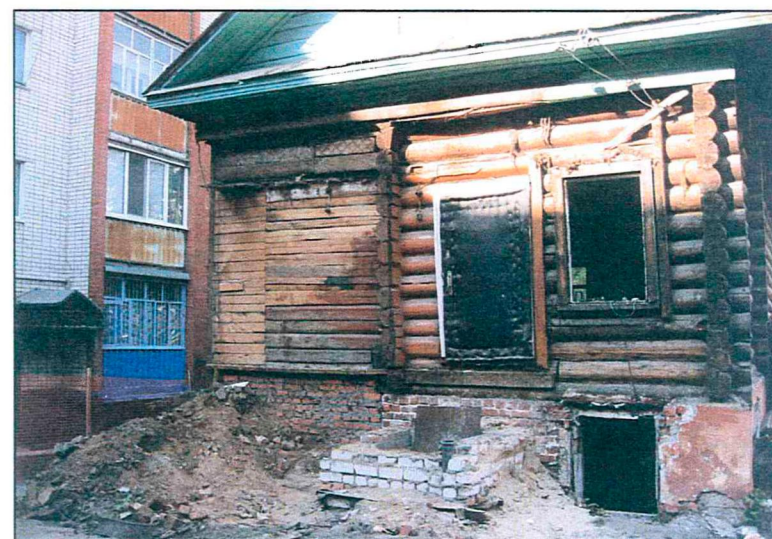
Общий вид после снятия обшивки. Задний фасад. Фото 2012г.
