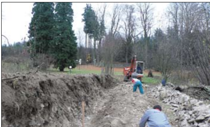
Výstavba nové opěrné zdi v roce 2005
