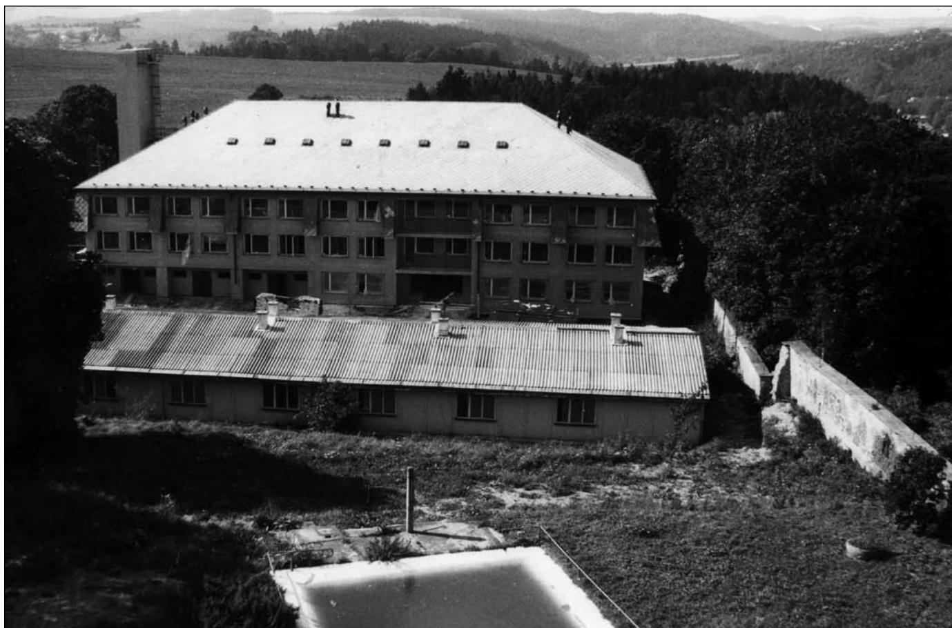
Výstavba ubytovny v roce 1987
