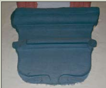
Tvarovaná patka klenby původního rytířského sálu
