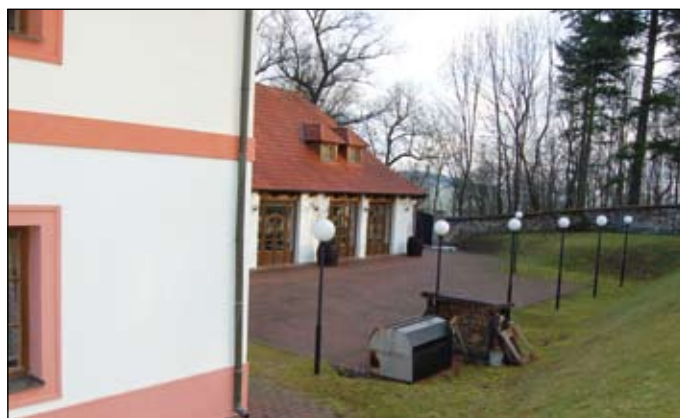
Přístavek po rekonstrukci
