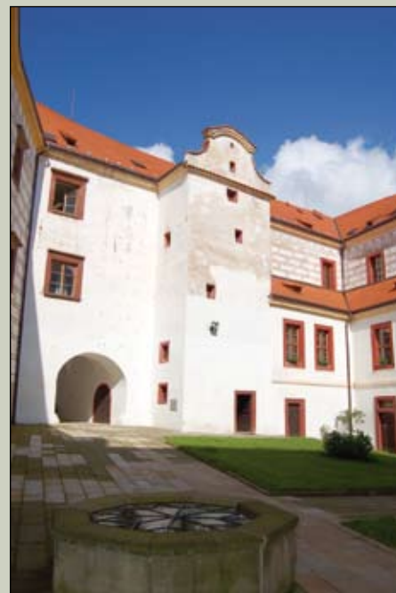
Vstup na druhé nádvoří pod původním hradem Veselé
