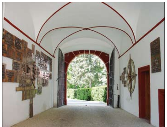
Zrekonstruovaný průchod na prvním nádvoří
