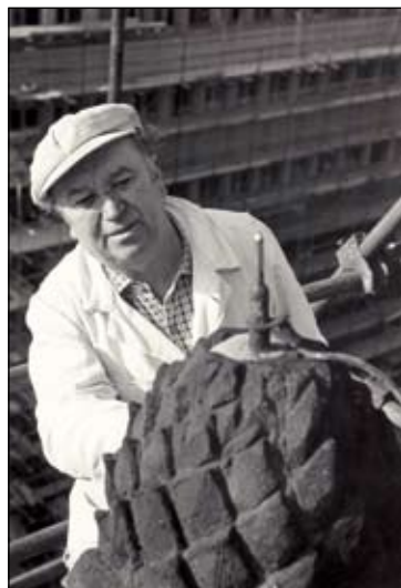
Sochař Miroslav Böswart při opravách fasád gotického hradu
