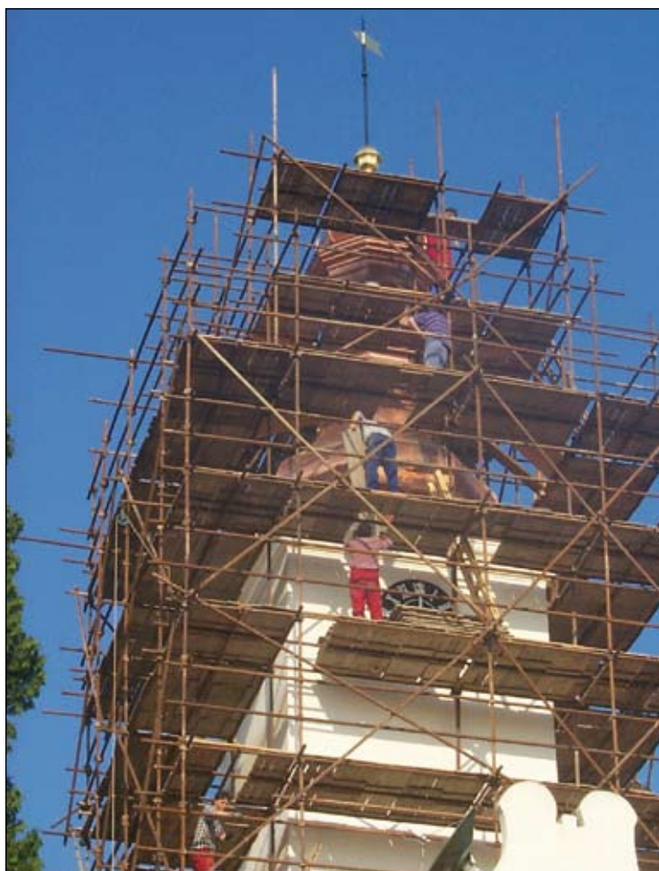
Oplechování věže měděnými pláty v roce 2000
