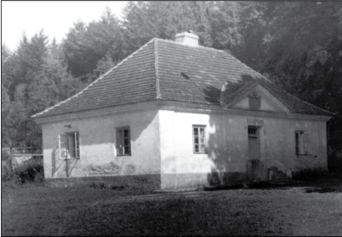
Domek zahradníka před rekonstrukcí
