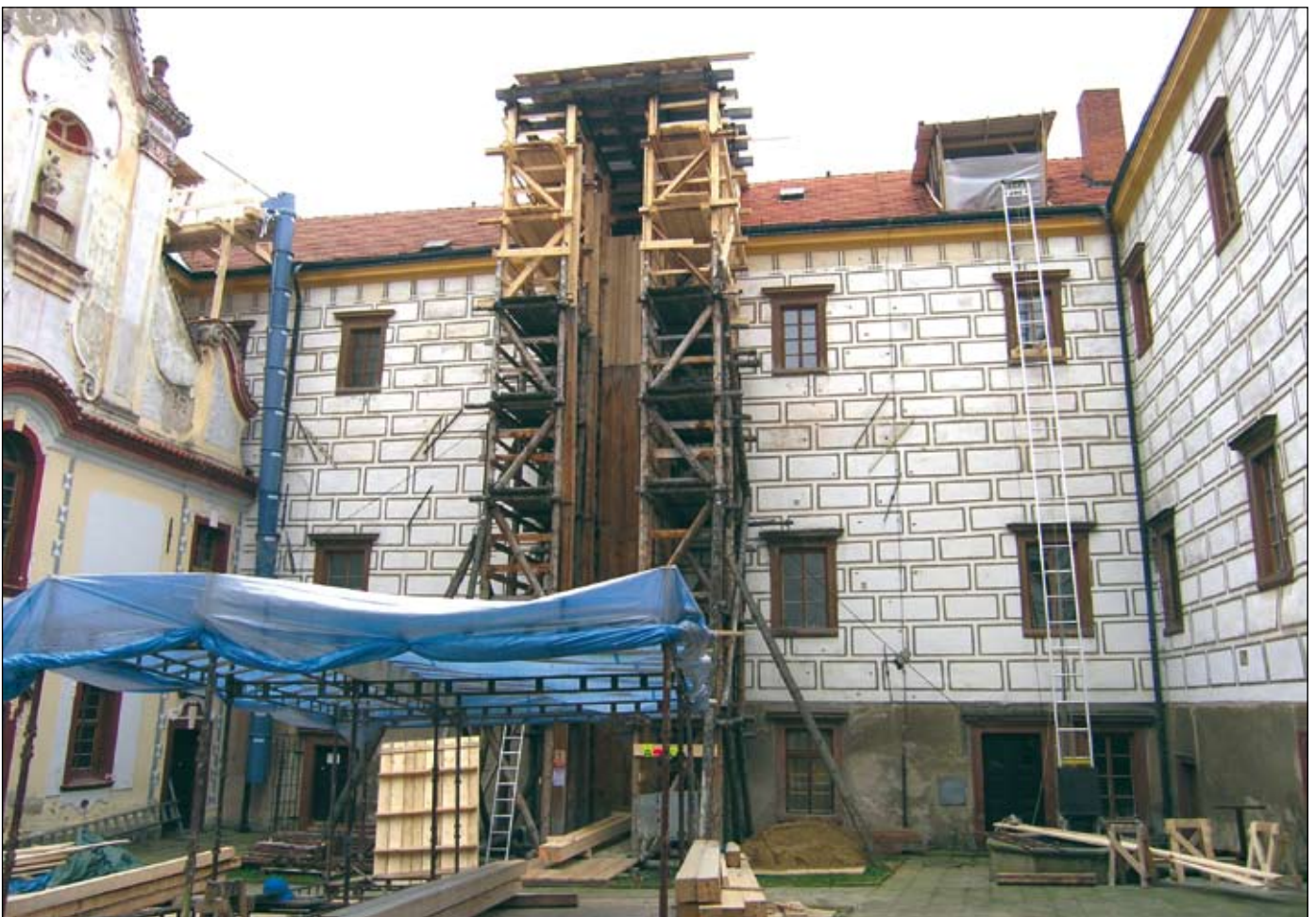
Stavební věž při rekonstrukci krovů v roce 2007
