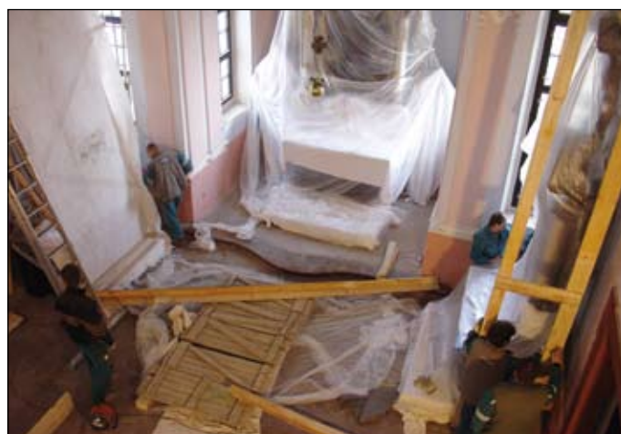
Rekonstrukce v březnu 2006
