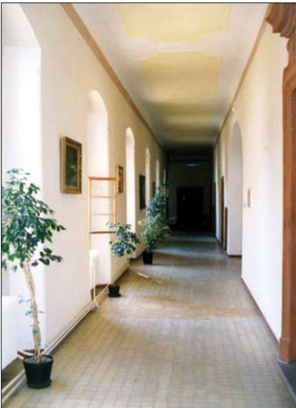
Zámecká chodba před rekonstrukcí podlahy a osvětlení
