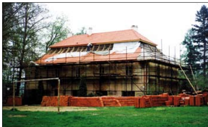
Lesovna při opravě střechy v roce 1993
