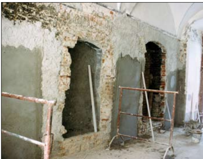
Rekonstrukce průchodu na prvním nádvoří v 90. letech
