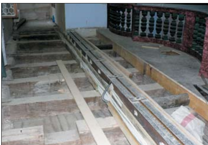
Oprava podlahy na balkoně u varhan v listopadu 2005
