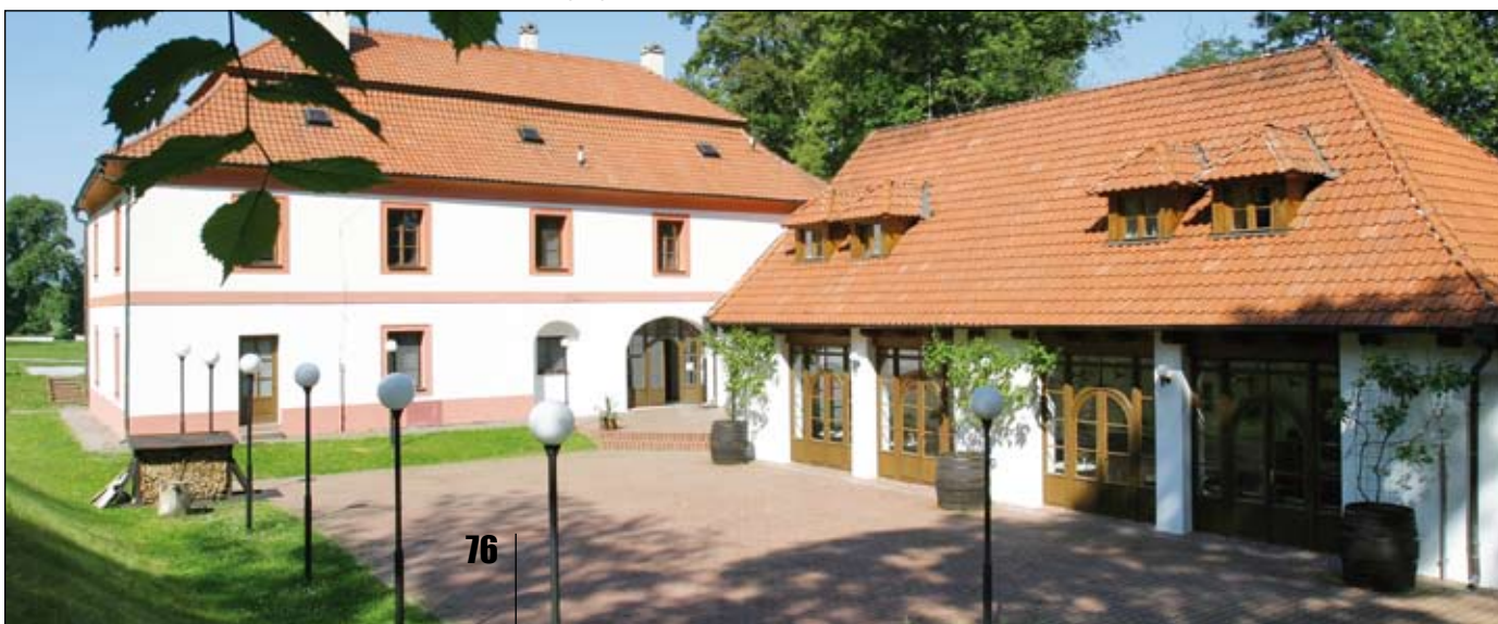
Lesovna po provedení rekonstrukce rok 2008
