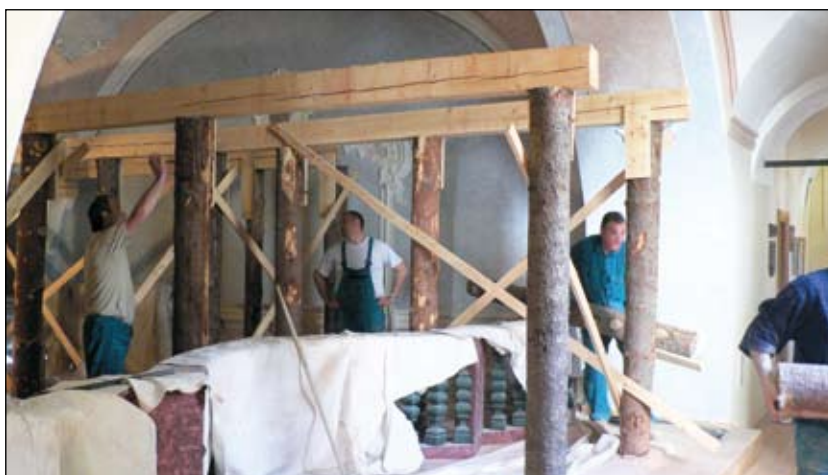
Oprava kaple po zásahu blesku v roce 2007
