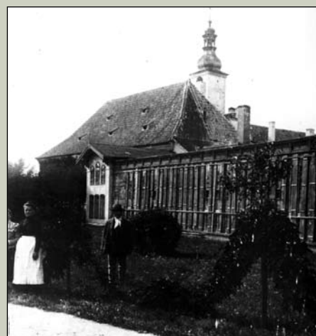
Skleník při jižním průčelí zámku
