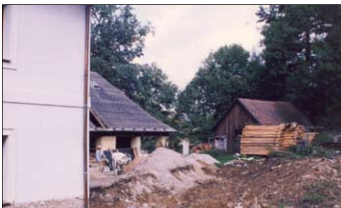
Rekonstrukce na přístavku k Lesovně v roce 1993
