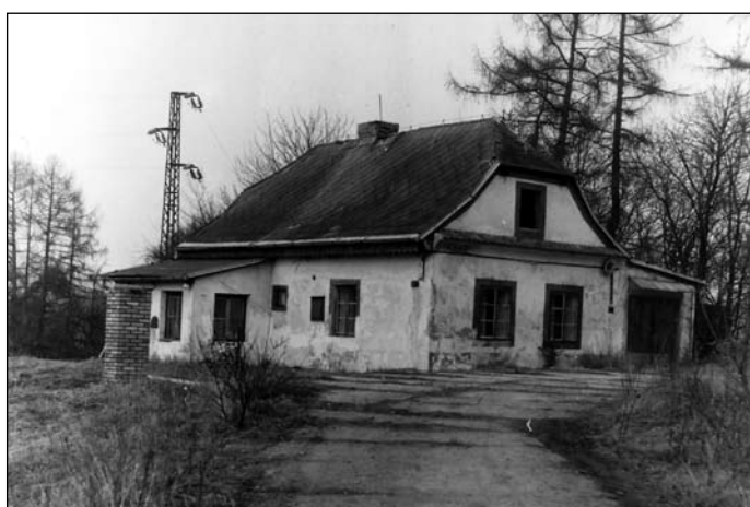
Domek sadaře před rekonstrukcí (1985)
