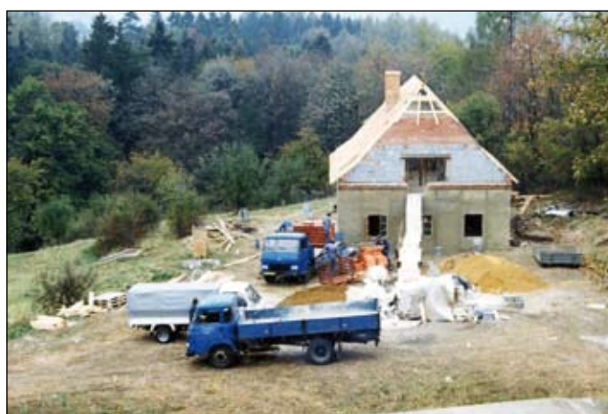
Rekonstrukce domku sadaře (1995)
