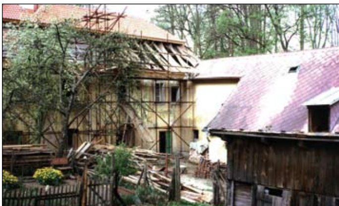
Lesovna během rekonstrukce (1992)
