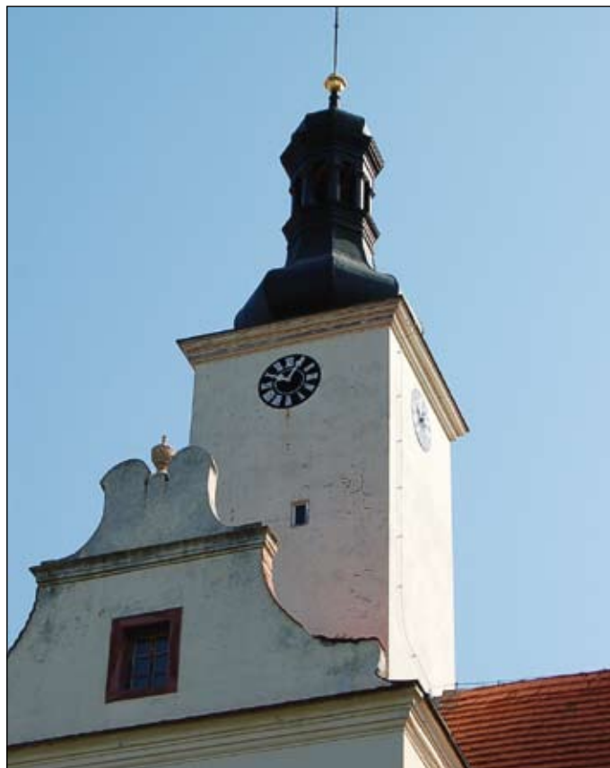
Současný stav věže
