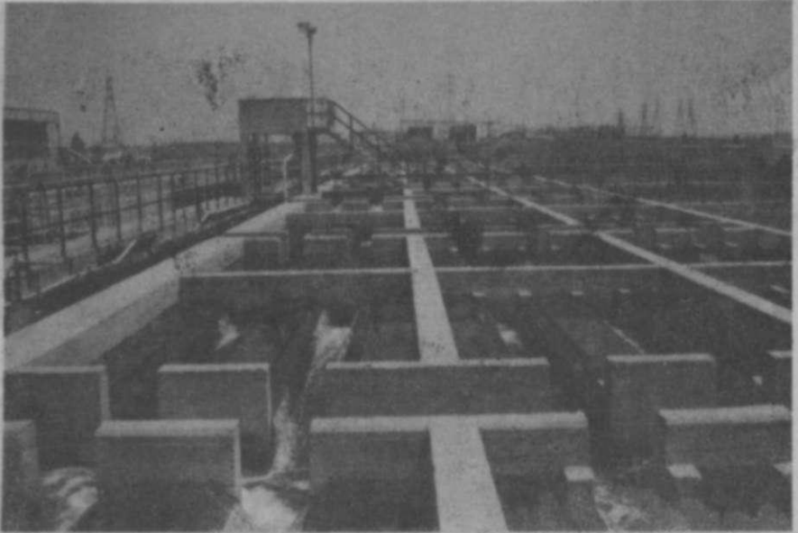
Foto: 3 (Kağıthane' de İski tarafından yapılmış İçme Suyu Arıtma Tesisi).
