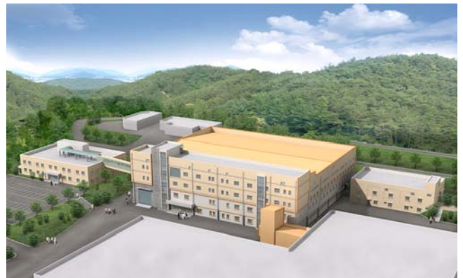
그림 8. 냉중성자 실험동 전경. 좌측에 이용자 등이 사용할 연구사무동, 우측에 시설계통을 포함하는 부속기동.
