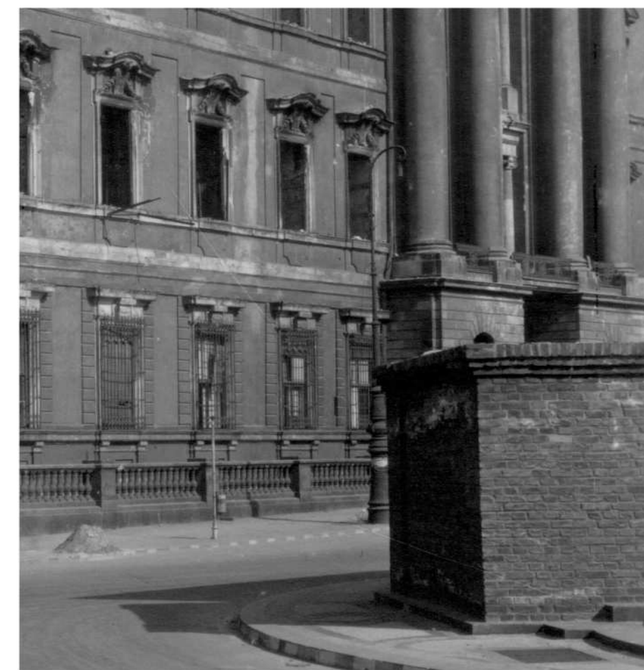
Abb.22: Zum Schutz vor Bombensplittern abgemauerter Brunnen (AV)
