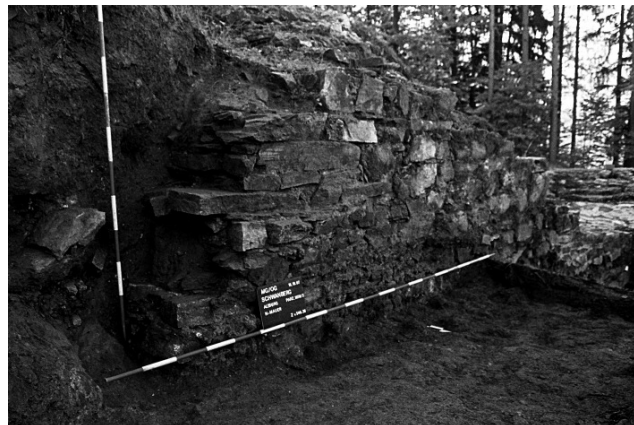
Abb. 59: Schwanberg. Festungsmauer östlich des Rondells mit Ecke in Richtung Süden.
