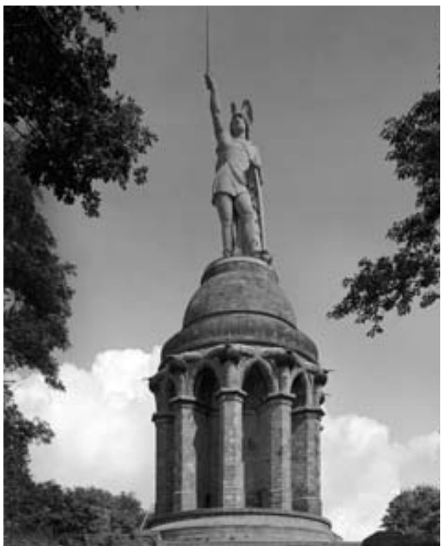
1 Ansicht des Hermannsdenkmals von Westen. 2006
