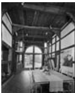
8 Kalletal-Lüdenhausen, Kotten, Wirtschaftsdiele. 2003.
