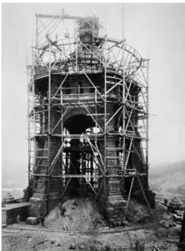
3 Das Kaiser-Wilhelm-Denkmal als Großbaustelle. Die Fotografie von 1896 verdeutlicht den technischen Aufwand und die Größe der Baustelle bei der über 2 Jahren dauernden Errichtung.
