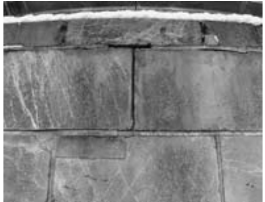
6 Detail Mauerwerk des Unterbaus. Oben bauzeitliche, unten nachgesägte Fugen. 2006.
