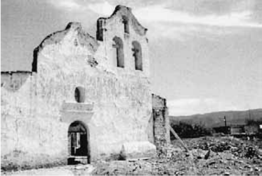
Figura 1. Iglesia de la misión en Lampazos, Nuevo León, en 1984 antes de la reconstrucción. Nótese el pánel arriba de la puerta principal.
